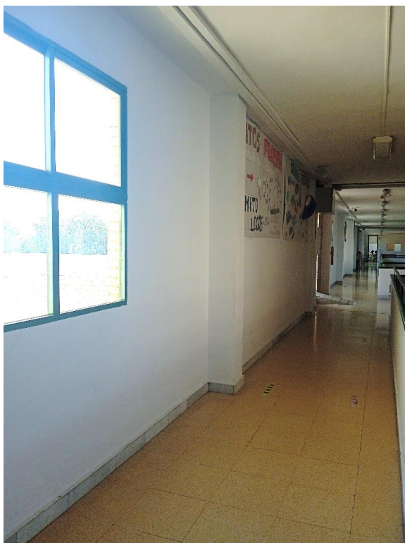
Pasillo desde el que se accederá al ascensor en planta alta.
