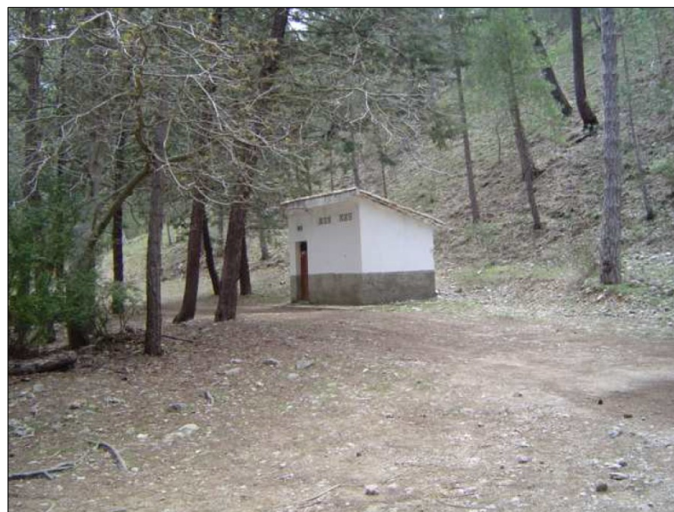
ALMACÉN GRUPO ELECTRÓGENO
