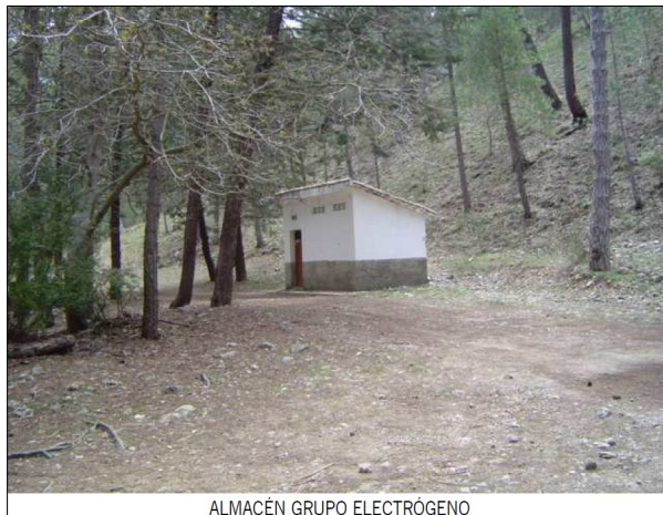
ALMACÉN GRUPO ELECTRÓGENO
