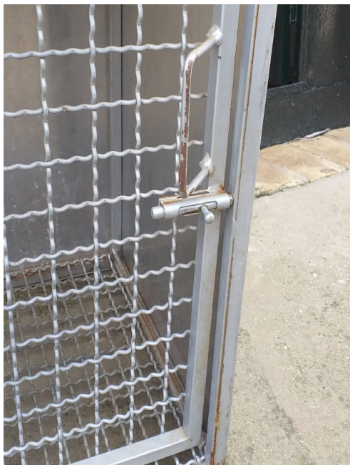
Imagen 4: Detalle tope inferior de la puerta de guillotina
