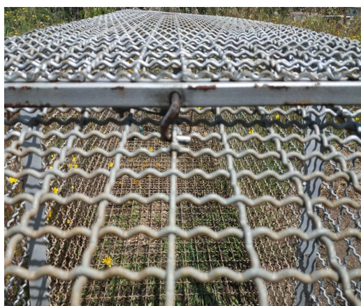
Imagen 5: Detalle de enganche de la puerta abatible
