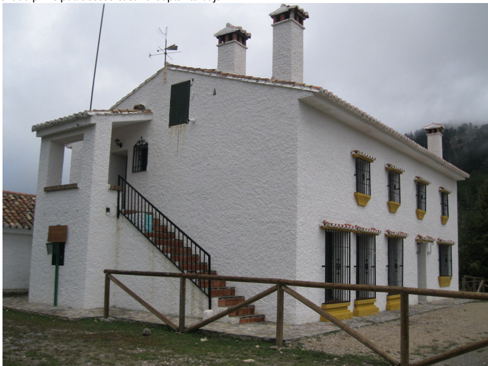
2. Fachada lateral izquierda: acceso a casa superior
