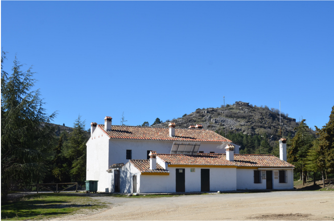
3. Fachada trasera y derecha: acceso patio, aseos públicos y oficina agentes forestales Casa rural planta baja
