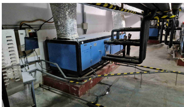
Fig. 4.1.B. Climatizador CLI-15 (Almacén Bienes Culturales) con humidificador
