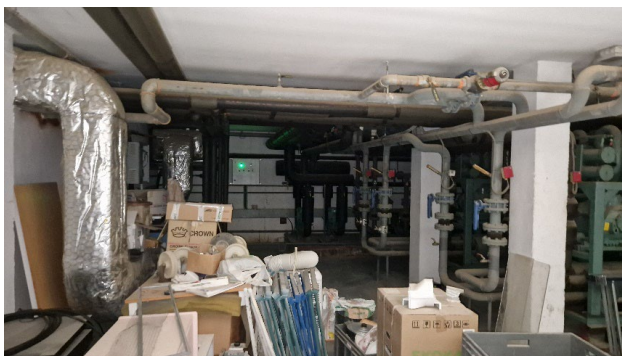
Fig. 3.3.A. Sala de máquinas (antigua producción) en planta de sótano
