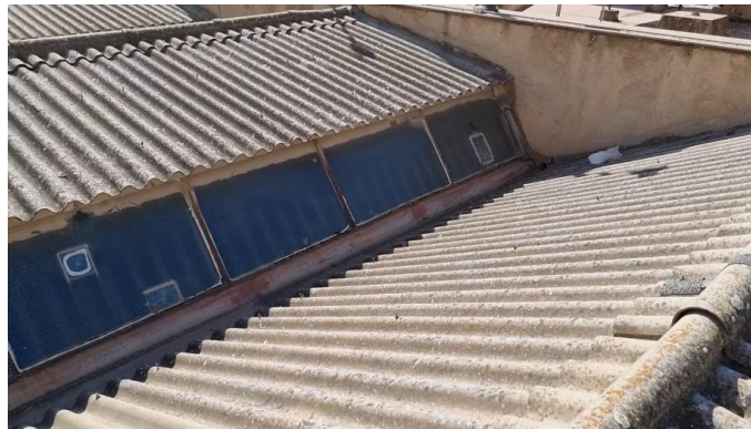
Vista de los canalones entre pendientes.
