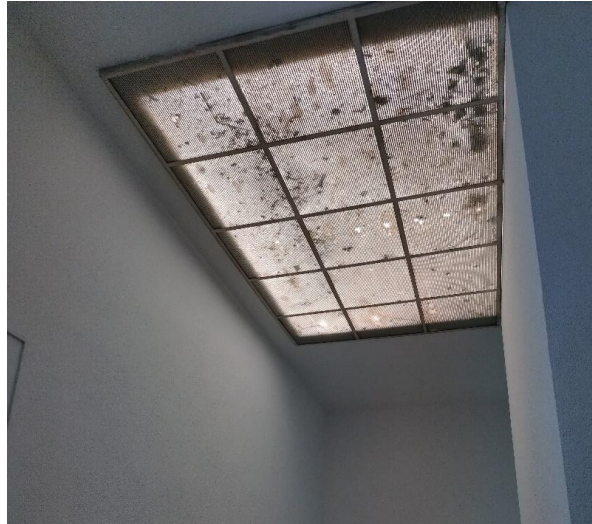
Vista interior y exterior del lucernario de cubierta T4
