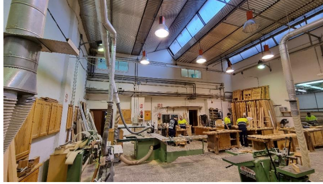
Vista de la cubierta en diente de sierra desde el interior de los talleres
