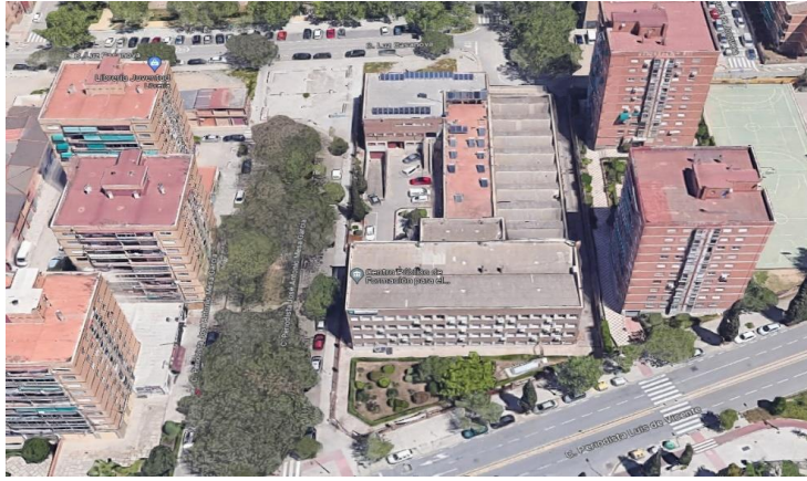
Vista aérea SUR
