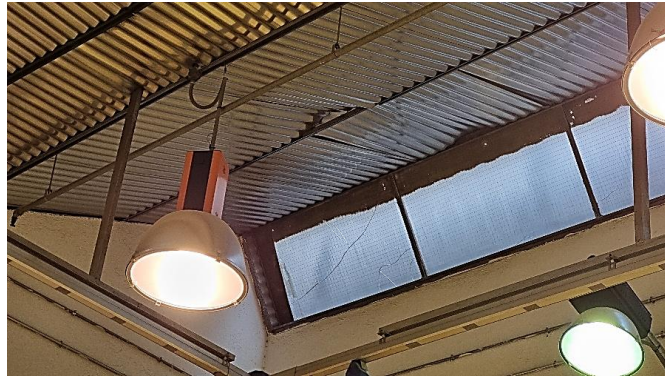
Vista de la cubierta en diente de sierra desde el interior de los talleres
