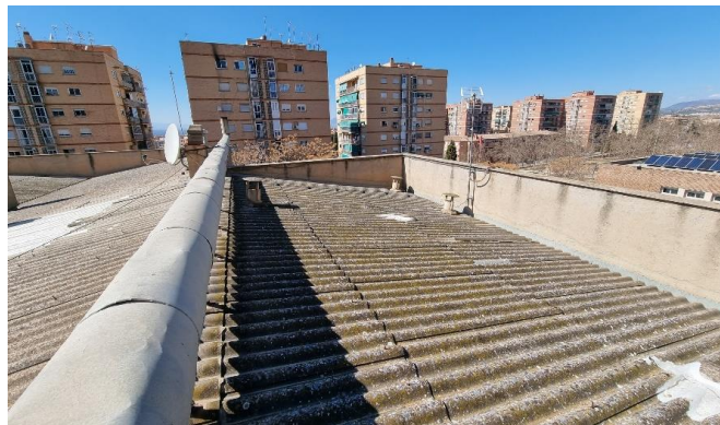
Vistas exteriores de la T4
