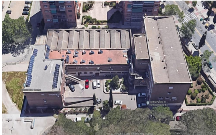
VISTA AÉREA OESTE. ACCESO AL EDIFICIO
