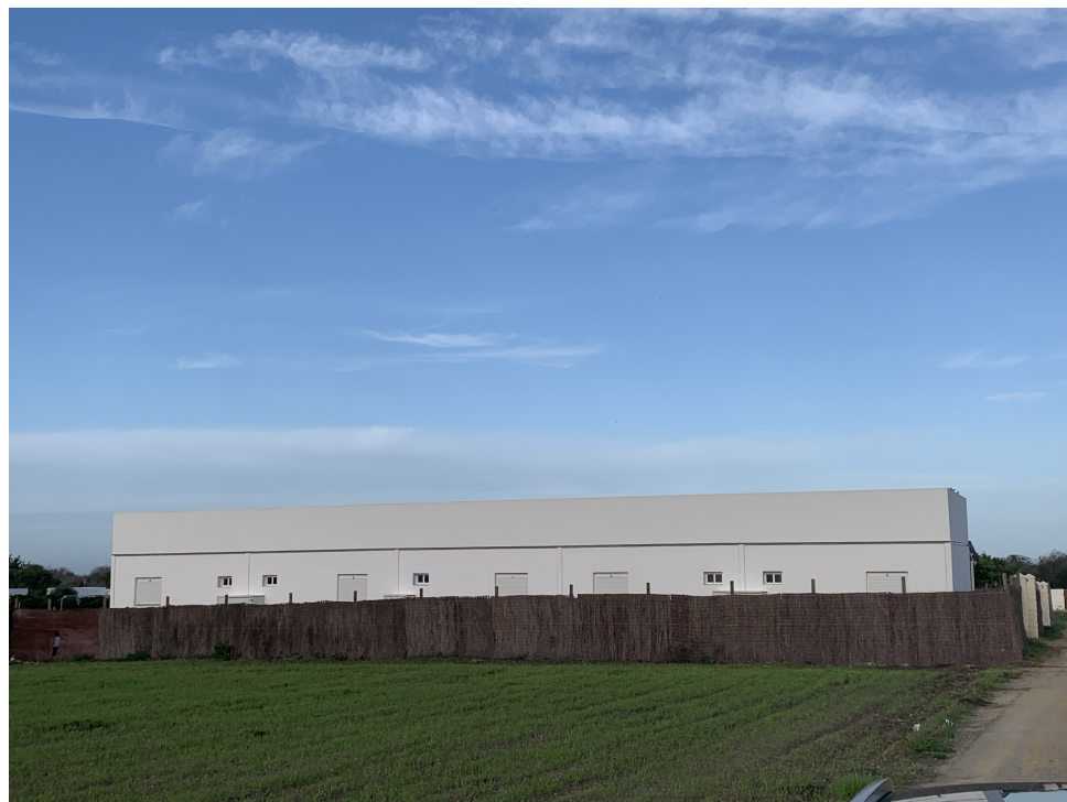
Foto 2. Fachada trasera ( Realizada en visita al exterior del edificio)
