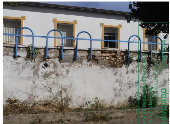
Fotografía N°08-09: ESTADO DEGRADADO DE LA RAMPA
