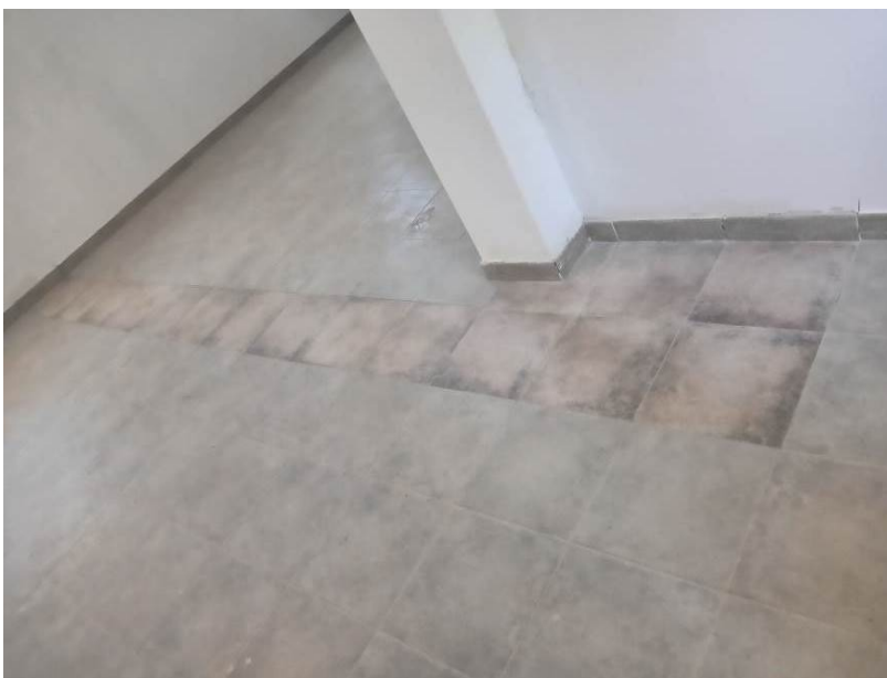
Franja de pavimento sustituida para canalizar las instalaciones
