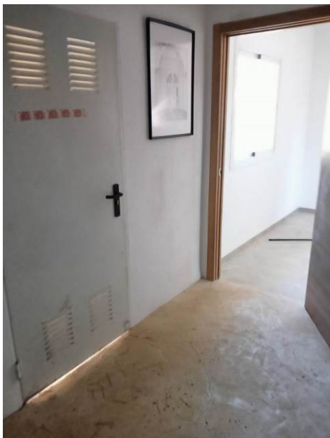
Puertas exterior e interior del baño
