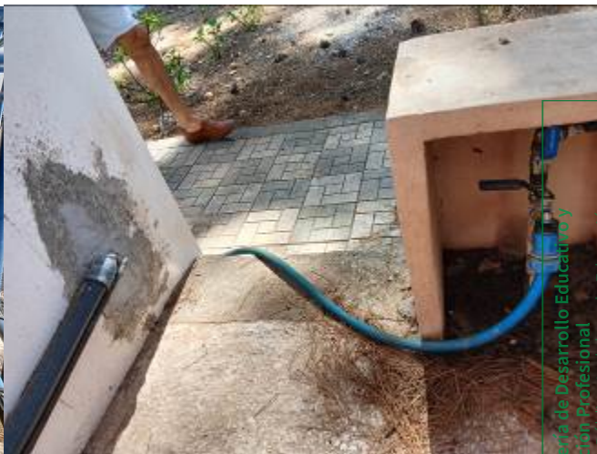
Franja de pavimento sustituida para canalizar las instalaciones
