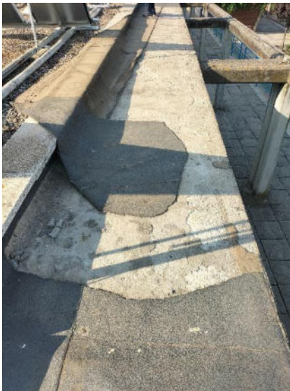
Deterioro Impermeabilización
