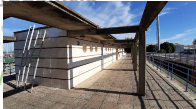
Cubierta sobre planta baja
