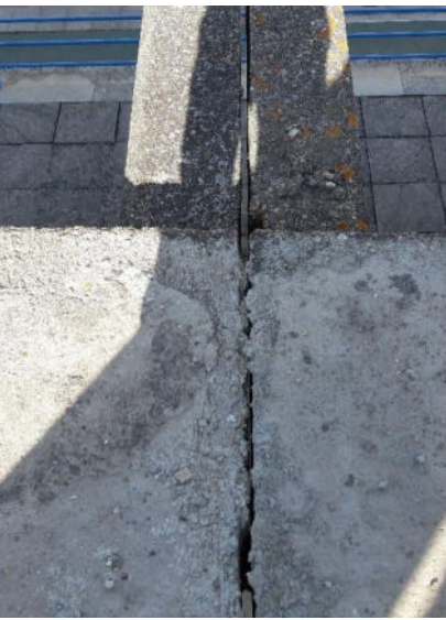
Juntas de dilatación planta alta
