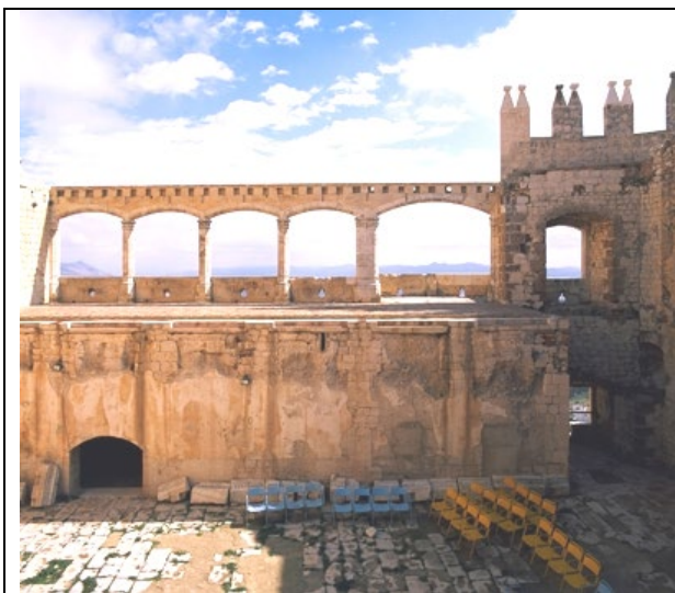
Vista anterior a 1992, donde se muestran ejecutadas las obras propuestas por el proyecto de 1987, referentes al alzado Este del Patio [Bodega y Botillería en nivel inferior, y nuevo forjado de piso en el Corredor de los Miradores]
