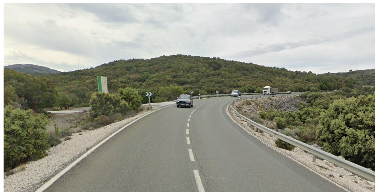
Fig. 1.- Vista del acceso al CV Las Conejeras (Sierra de las Nieves) junto a la Ctra. A-397 Se plantea realizar un acceso directo.
