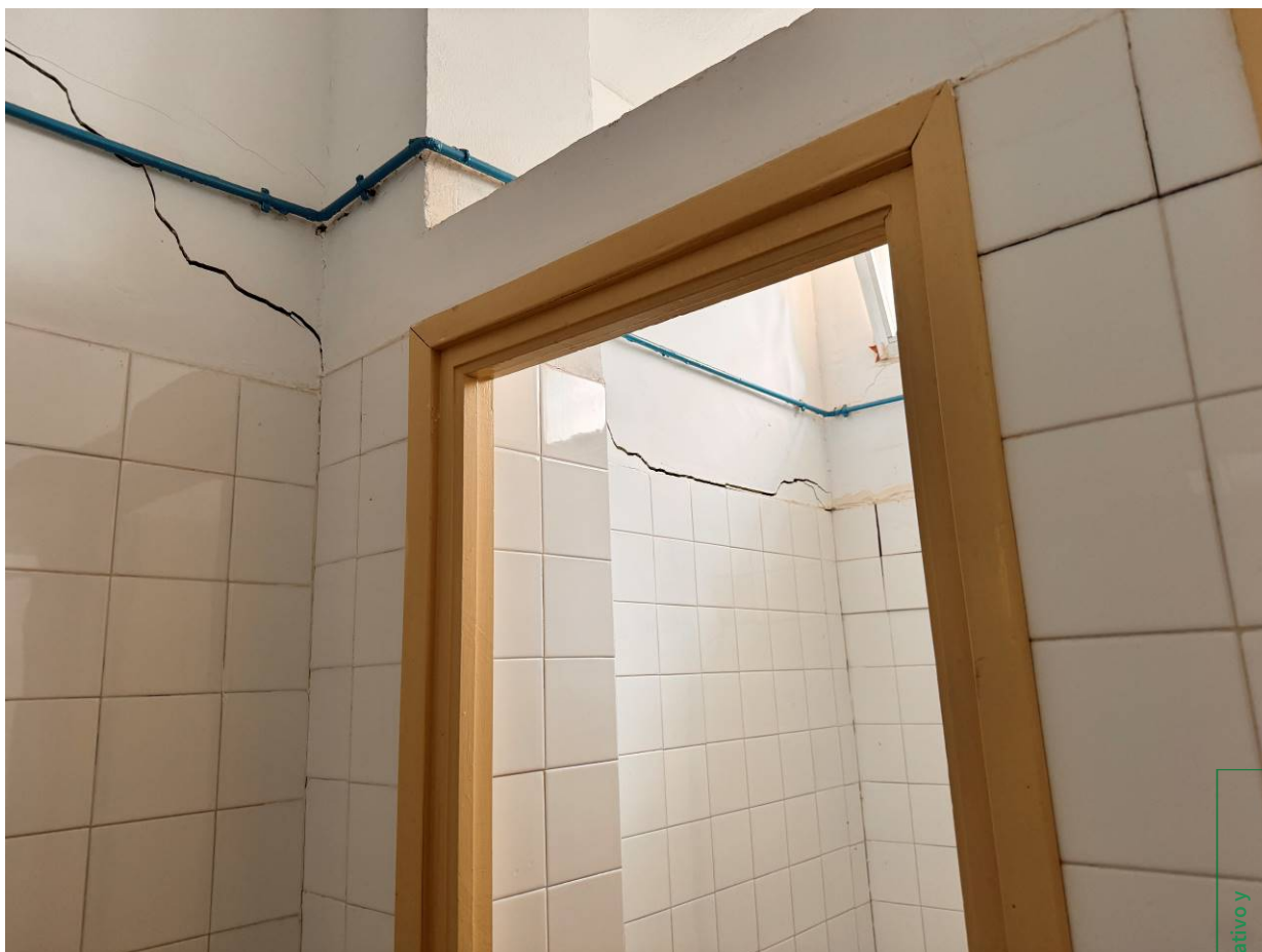
Foto 6. Interior del edificio. Aseos
