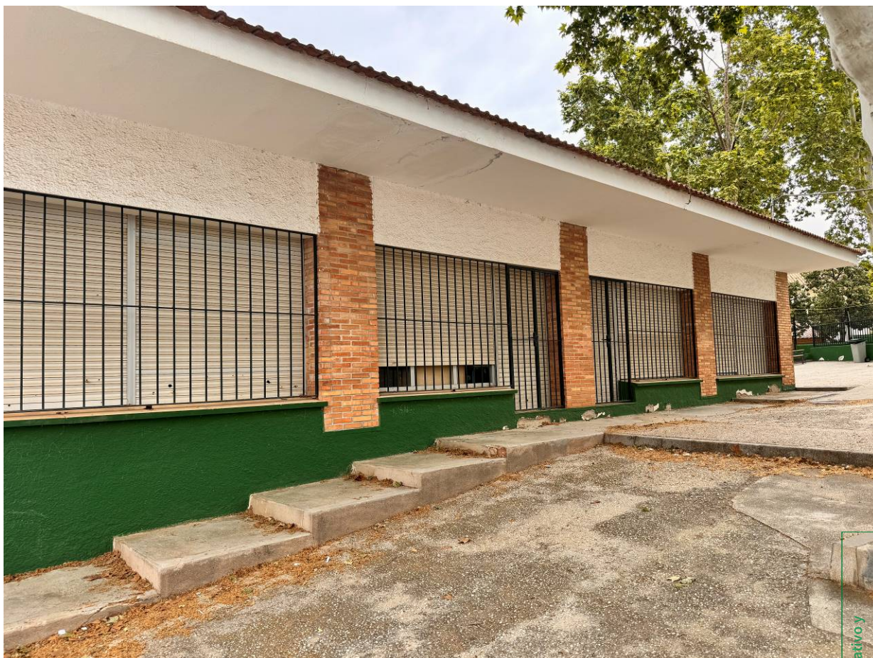
Foto 4. Fachada lateral del edificio.
