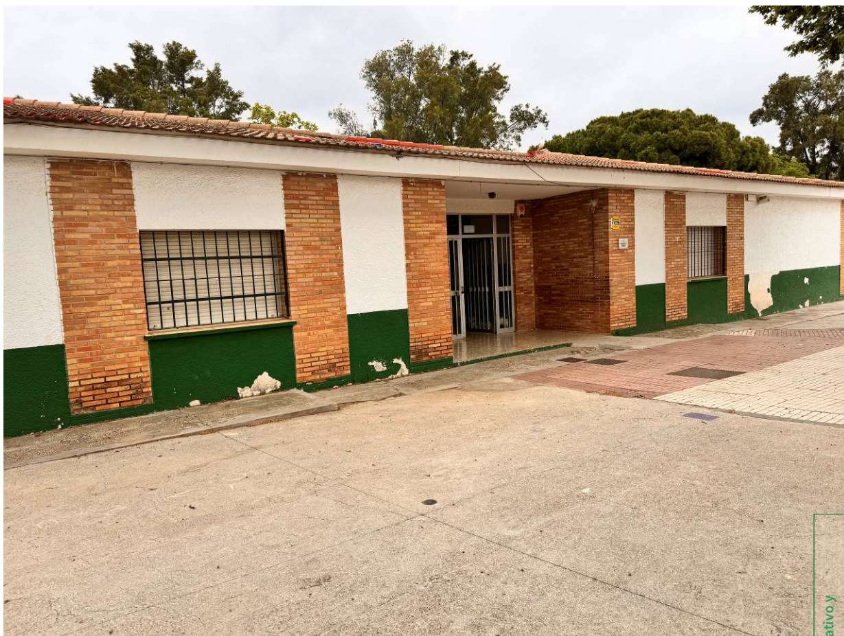
Foto 2. Fachada principal y acceso
