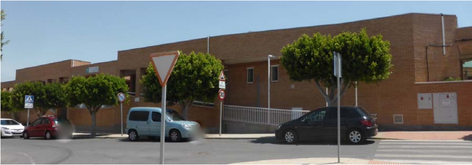
Vista general desde la calle Levante de la Escuela Infantil Las Norias, objeto de actuación.
