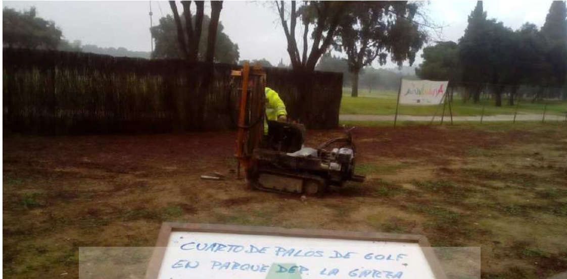
SONDEO CATA. EMPLAZAMIENTO
