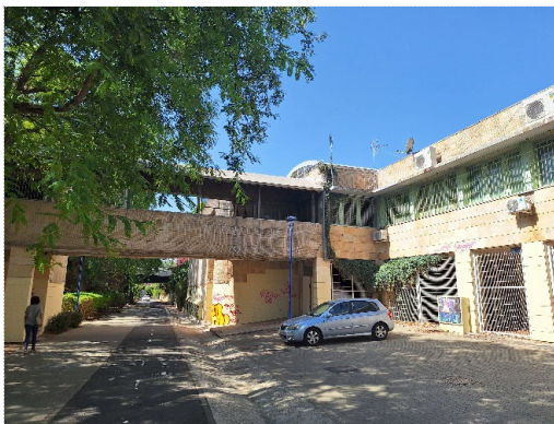
Pasarela edificada de conexión.
