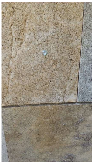
Fijaciones mecánicas del aplacado e instalación de redes de protección.
