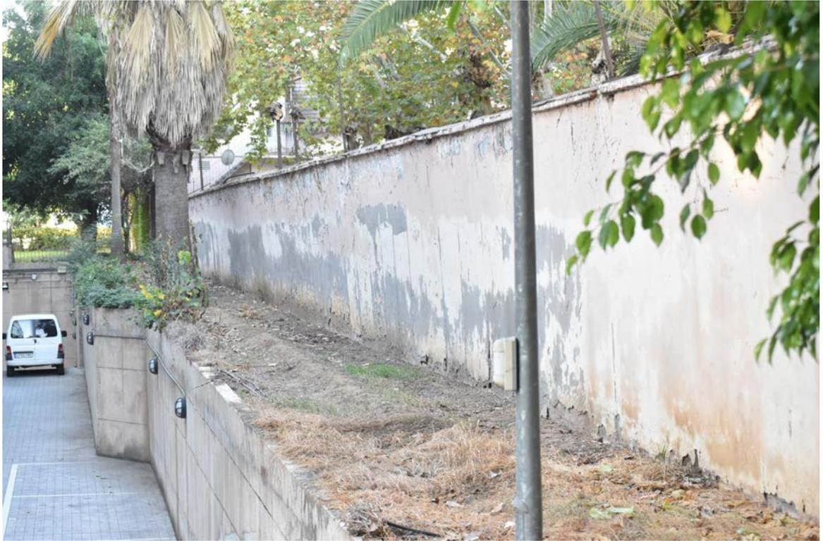
8. Detalle de la cara exterior del muro. Se puede observar el mal estado del revestimiento y de la albardilla
