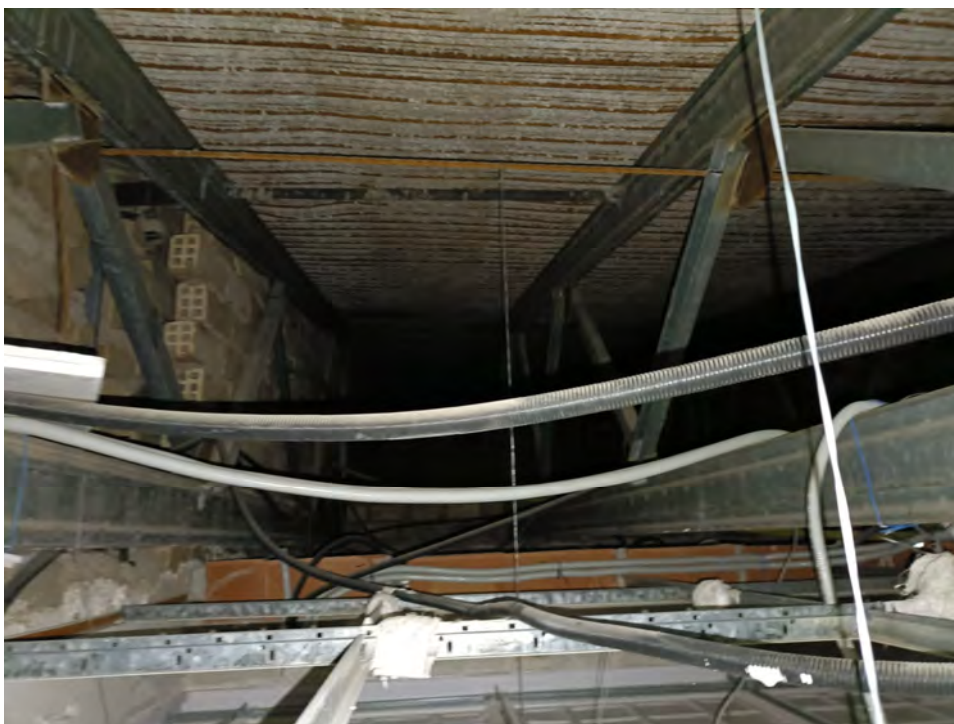
F06: Vista de la estructura de cubiertas
