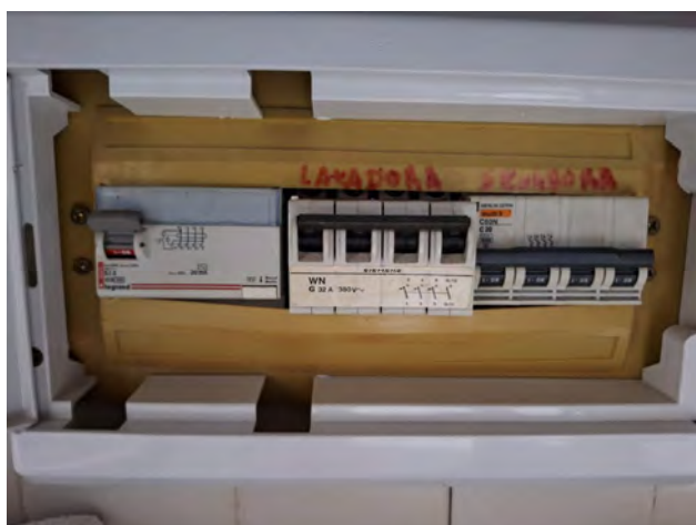
F04-F05: Cuadros eléctricos a sustituir.
