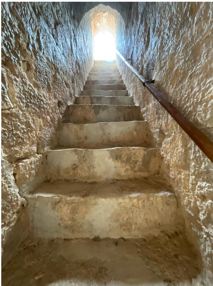
Escalera interior. De nivel 2 a cubierta
