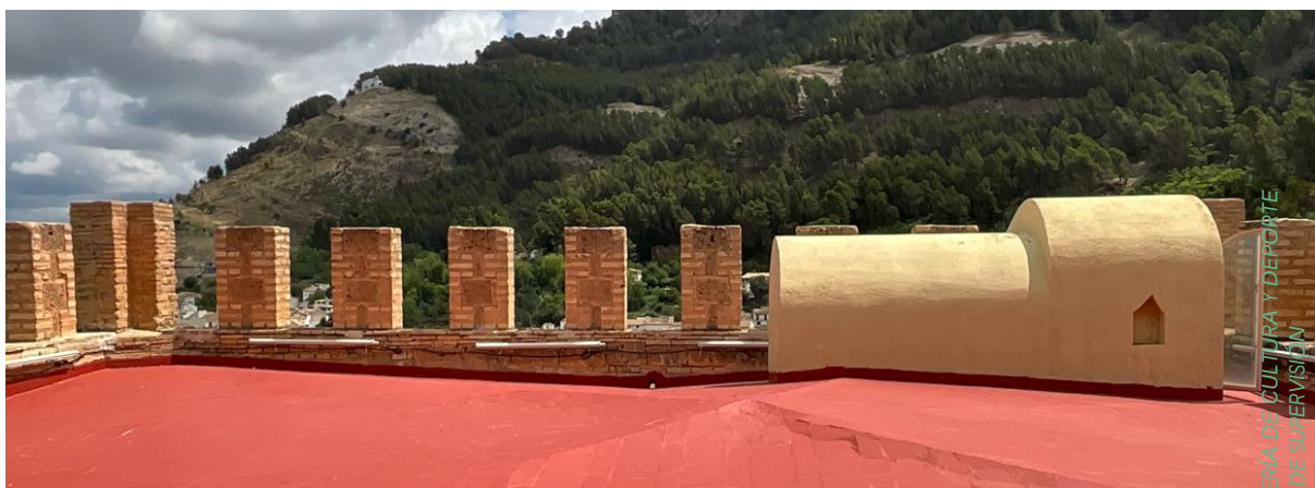
Detalle. Castillete de salida a la cubierta de la Torre del Homenaje
