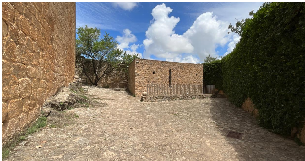
Vista general del Patio de Armas
