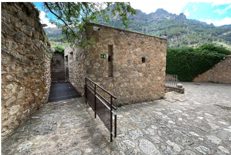
Vista del volumen edificado en el Patio de Armas.
