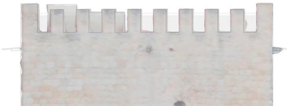
Vista de la barandilla desde el exterior.
