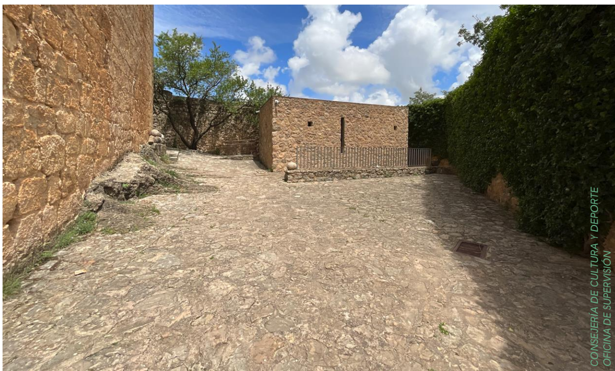
Vista general del Patio de Armas
