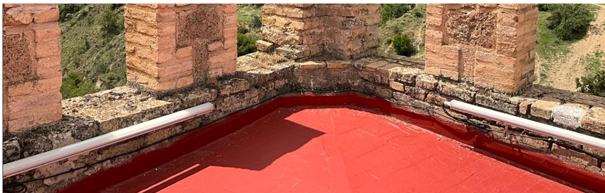
Detalle. Instalación de iluminación
