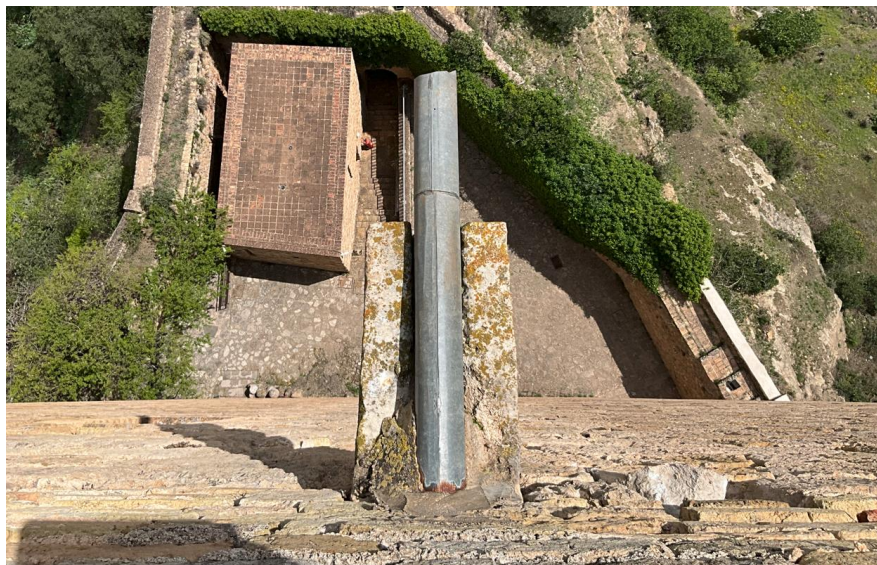
Detalle de gárgola que mantiene el elemento de piedra.
