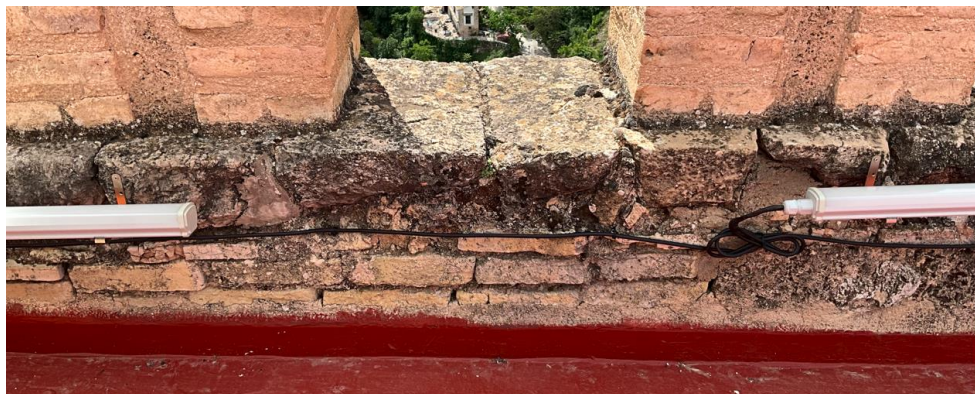
Detalle. Remate de muro con elementos de piedra
