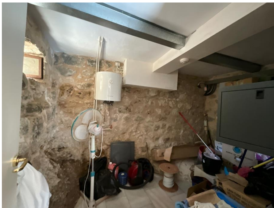
Interior de la planta semisótano (habitación secundaria)
