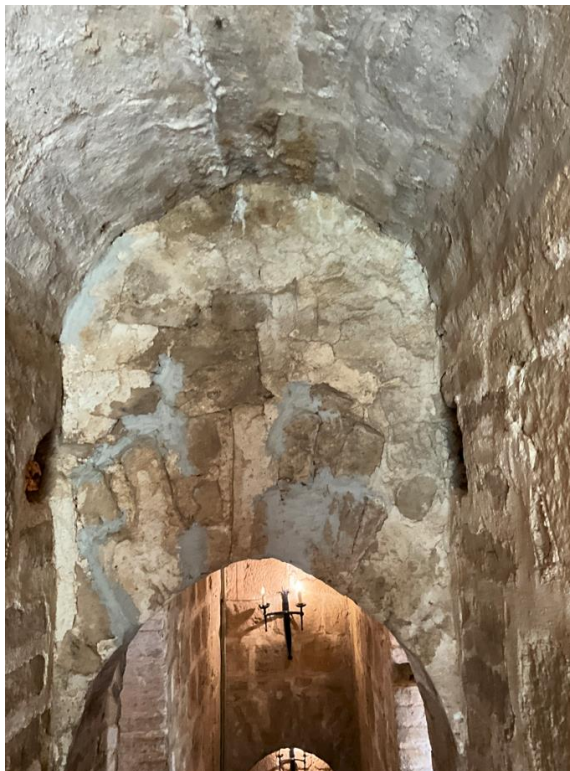
Detalle de paramentos en el tramo 3 de la escalera
