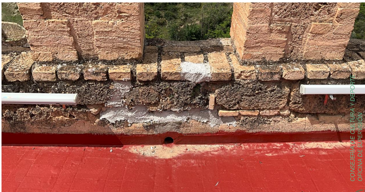
Detalle. Reparación realizada con mortero de cemento
