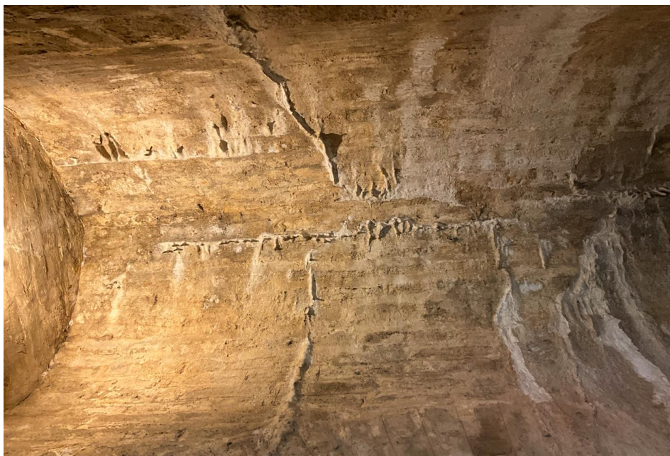
Detalle de bóveda en el tramo 3 de la escalera
