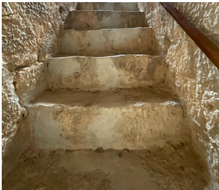
Detalle de reparación de escalones con morteros de cemento
