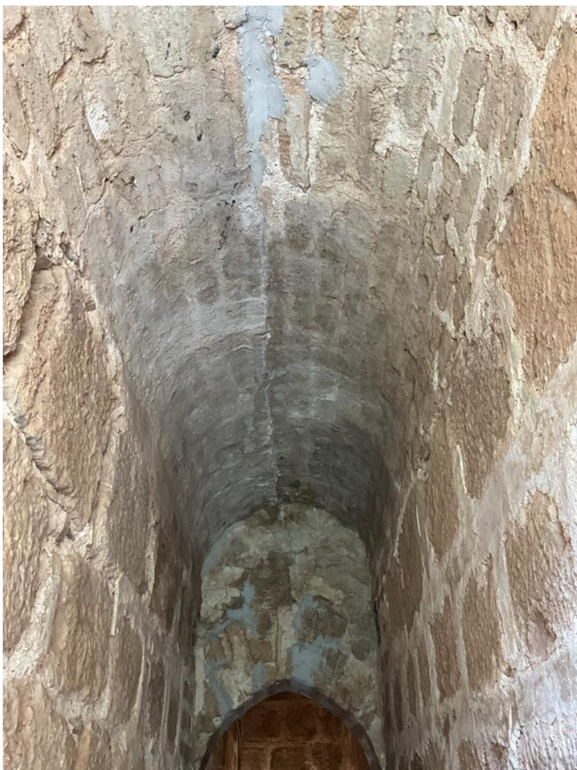
Techo de escalera. Tramo nivel 1 a nivel 2.
