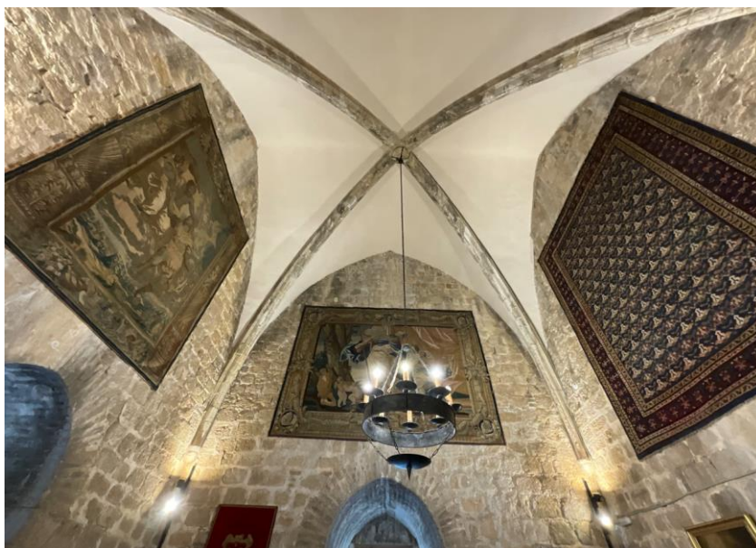
Nivel 2. Vista de la Bóveda de crucería
