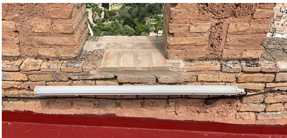
Detalle. Reparación con ladrillo nuevo y mortero de cemento
