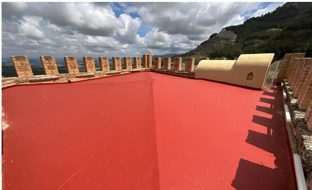
Vista general de la cubierta
