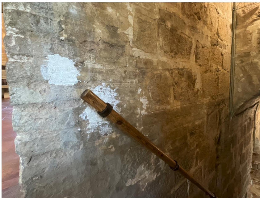
Detalle de paramentos verticales en el tramo 2 de la escalera
