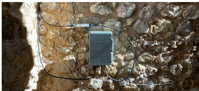
Elementos anclados a la muralla
