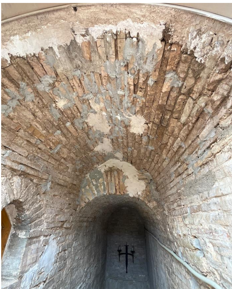
Detalle de bóveda de ladrillo en el interior del castillete de acceso a cubierta
