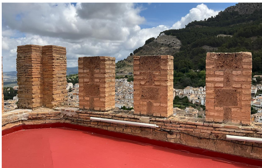
Detalle de cubierta y almenas
