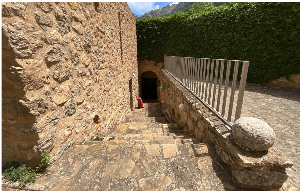
Escaleras de acceso al recinto interior de Defensa
