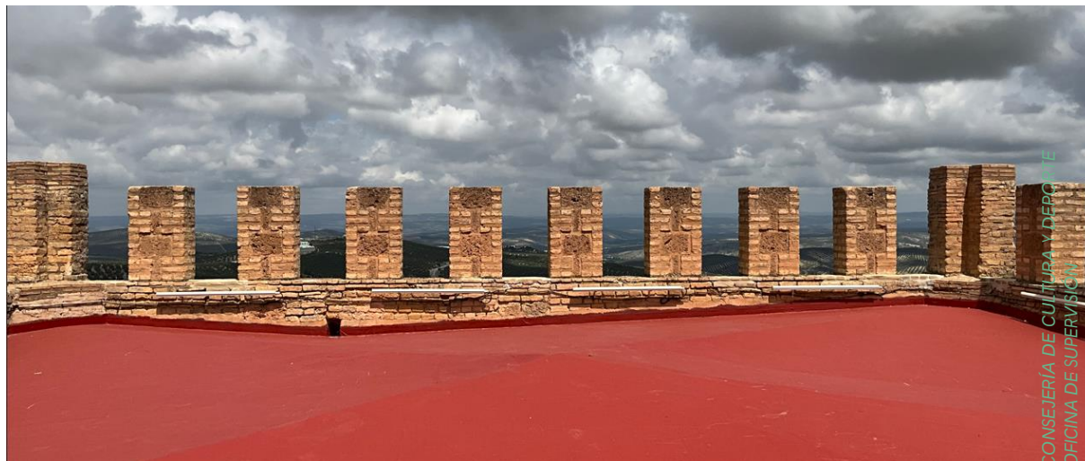
Cubierta. Vista del lado noroeste
