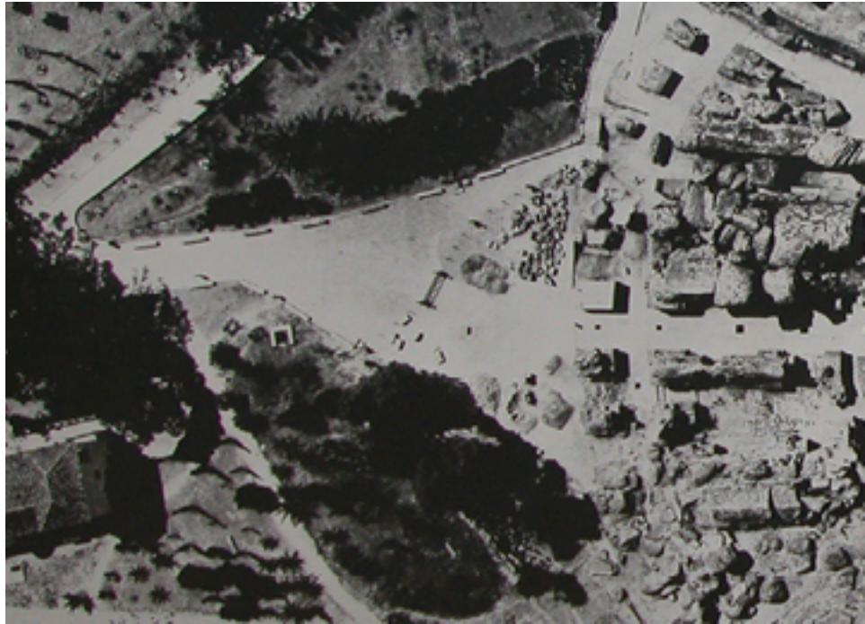
7. Detalle de la fotografía aérea de 1983 donde se puede ver los bancos junto al talud, sin muro de contención
