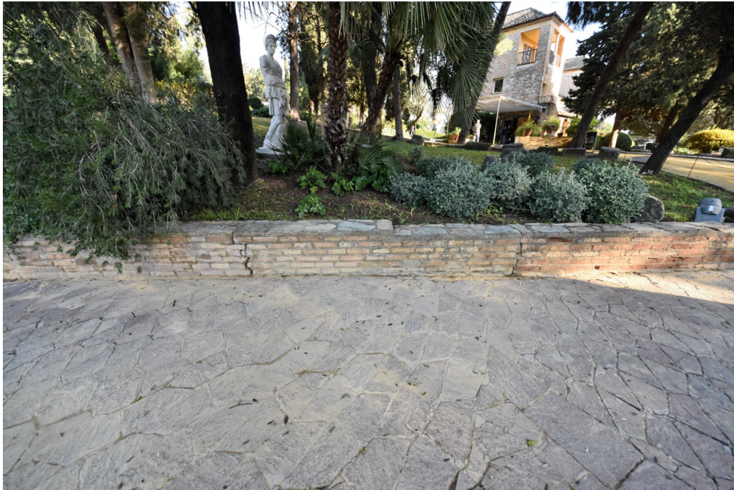
15. Detalle de la grietas del primer tramo de muro
