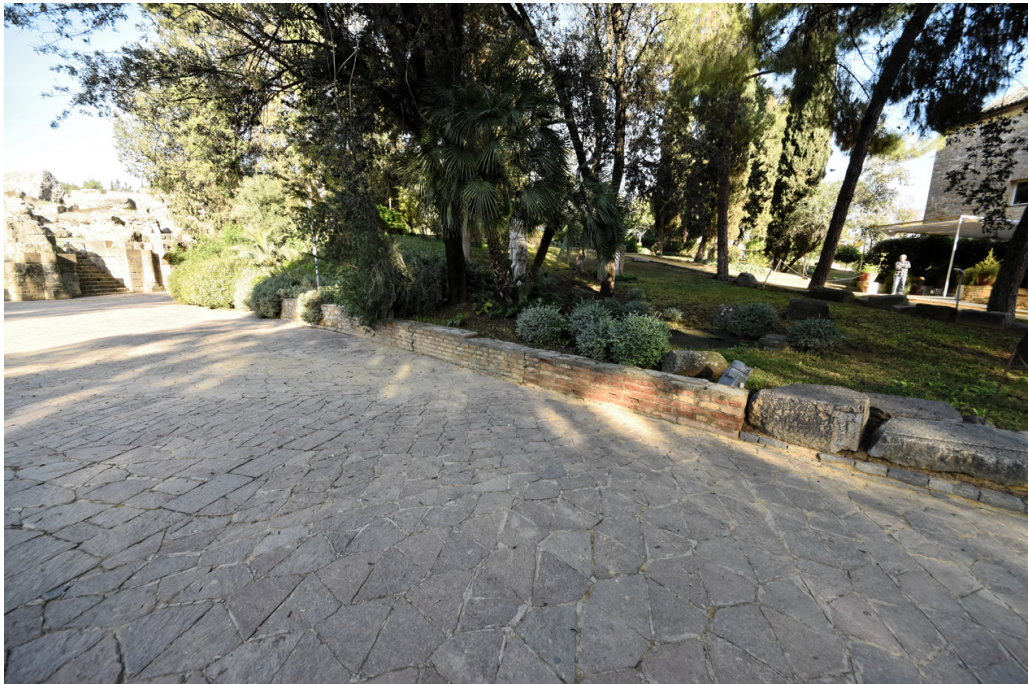
10. Explanada de acceso con el muro de contención a la derecha.
