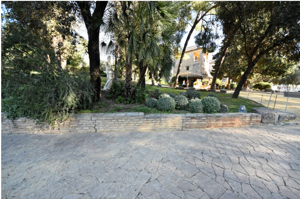
12. Primer tramo del muro realizado con fábrica de ladrillo, probablemente uno de los bancos existentes inicialmente.
