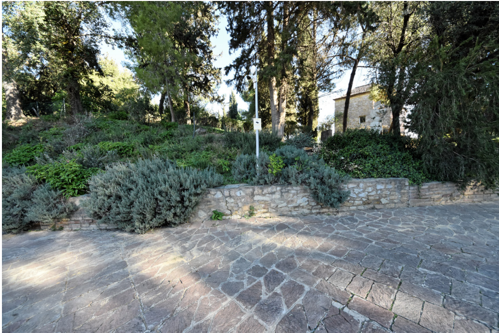
13. Tramo intermedio del muro realizado mampostería irregular.
