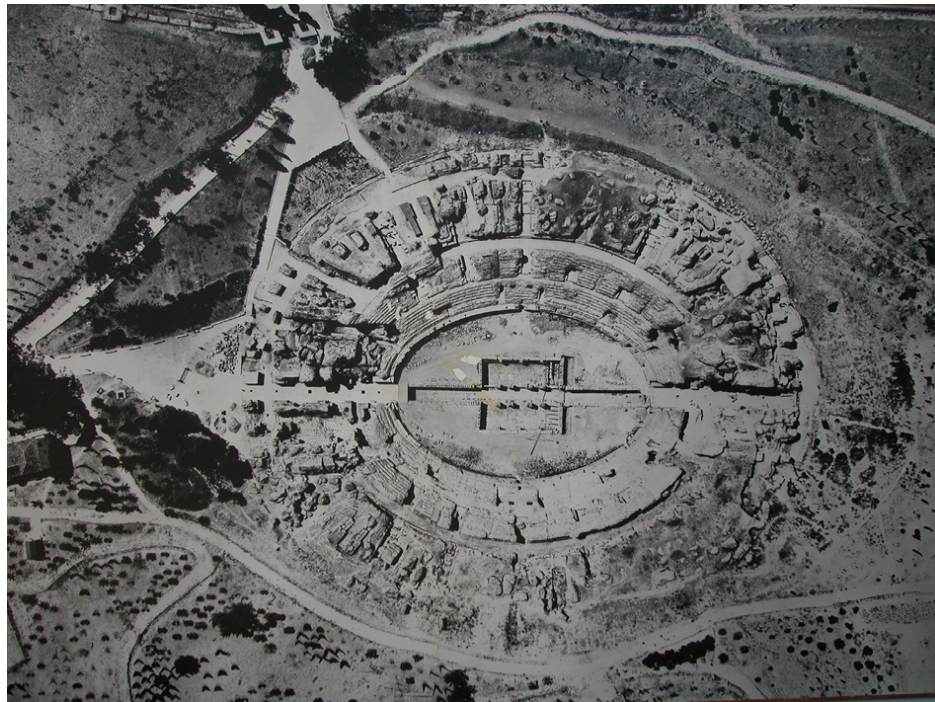
6. Fotografía aérea de 1983 donde se puede ver los bancos junto al talud, sin muro de contención
