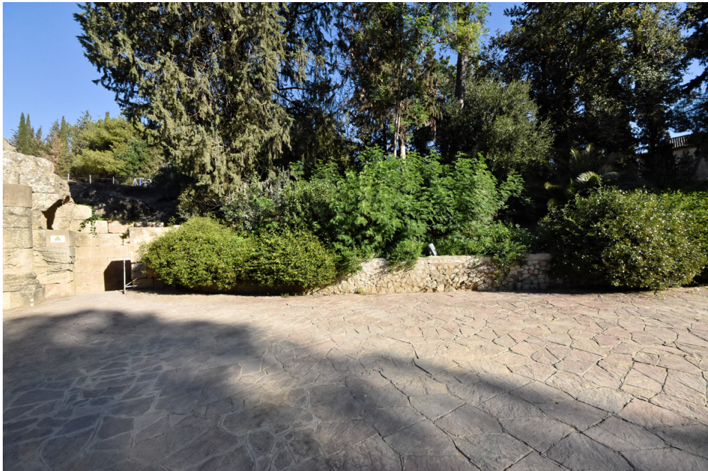
14. Tramo final del muro realizado mampostería irregular.
