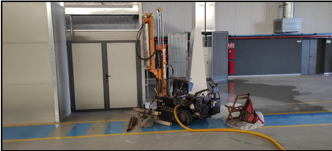
EMPLAZAMIENTO ENSAYO REFERENCIADO COMO SR-3.
