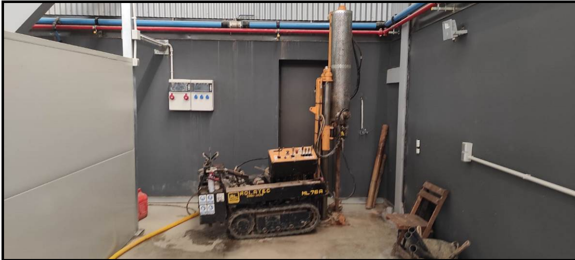
EMPLAZAMIENTO ENSAYO REFERENCIADO COMO SR-1.
