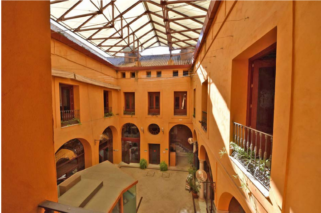
20. Patio 2 desde la planta alta
