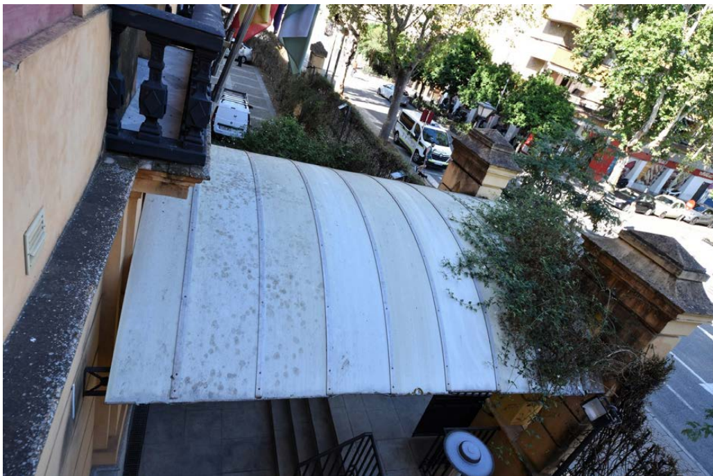
101. Vista de la cobertura de placas de policarbonato de la pérgola de acceso desde la plaza de la Gavidia.
