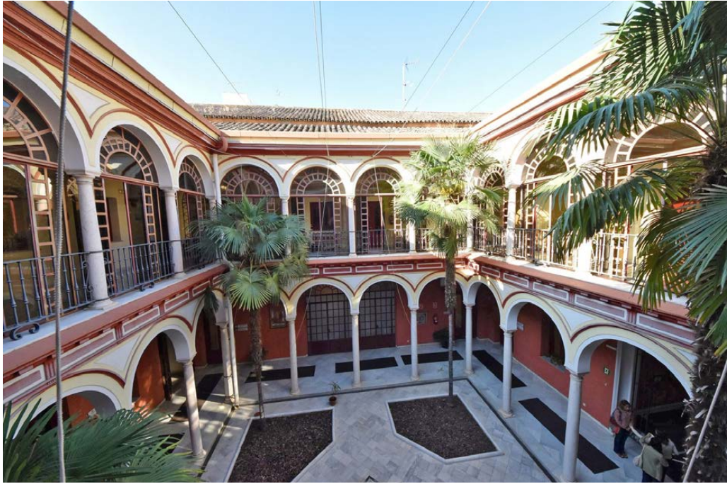
14. Patio principal desde la galería de la planta alta
