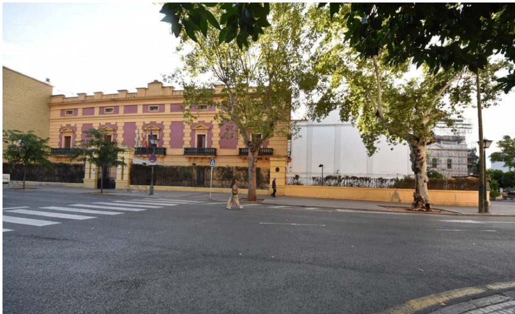
3. Fachada a la plaza de la Gavidía incluyendo el jardín delantero, que se emplea como aparcamiento en la parte izquierda
