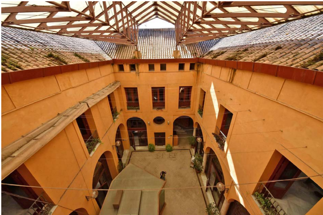
21. Patio 2 desde el nivel de las cubierta y montera
