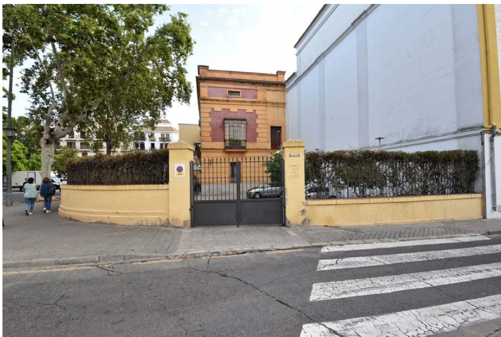
4. Fachada hacia la plaza de la Concordia y acceso al aparcamiento
