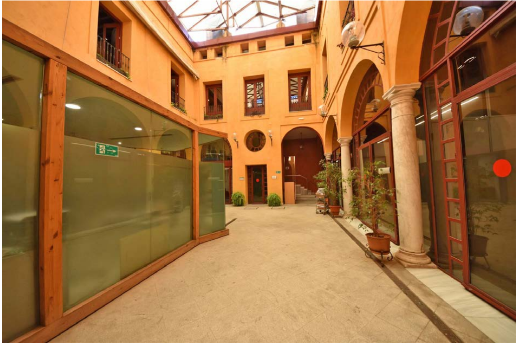
16. Patio 2, dentro de la antigua casa de los marqueses de Montefuerte, vista hacia la calle Jesús del Gran poder
