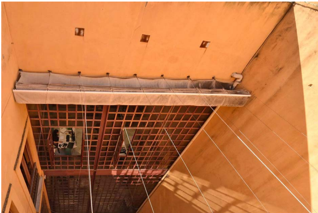
104. Anclajes del toldo del patio 5
