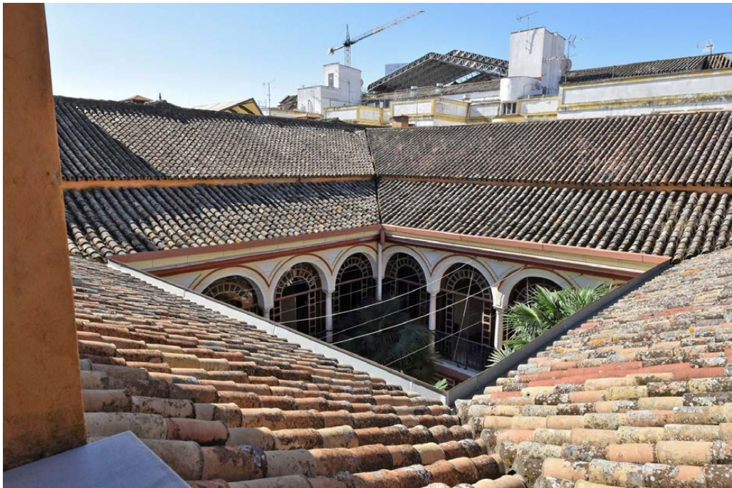
15. Cubiertas alrededor del patio principal
