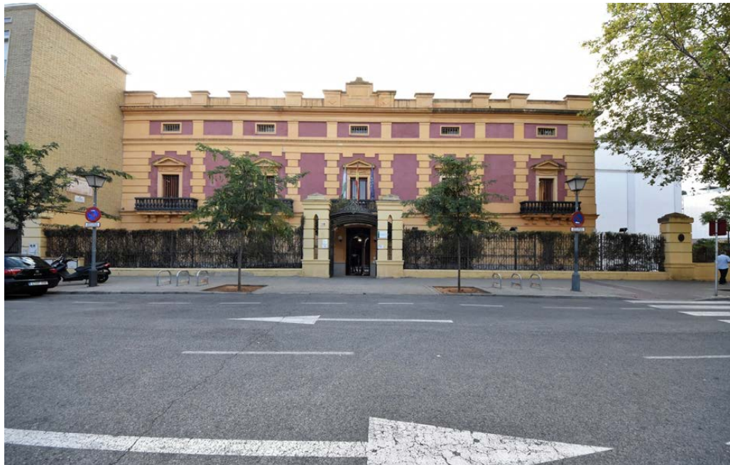
2. Fachada principal a la plaza de la Gavidía
