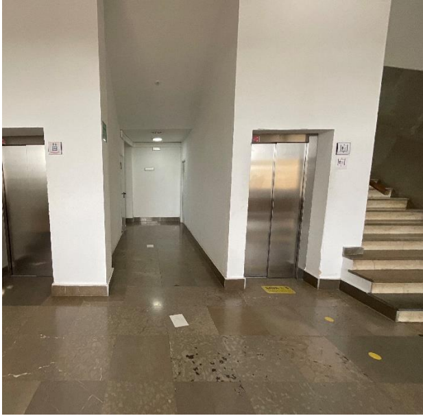
C.1.1. Modernización ascensores, sistema de control
