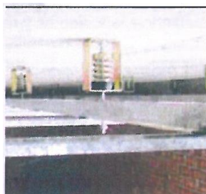
Amortiguadores suspendidos en techo.
