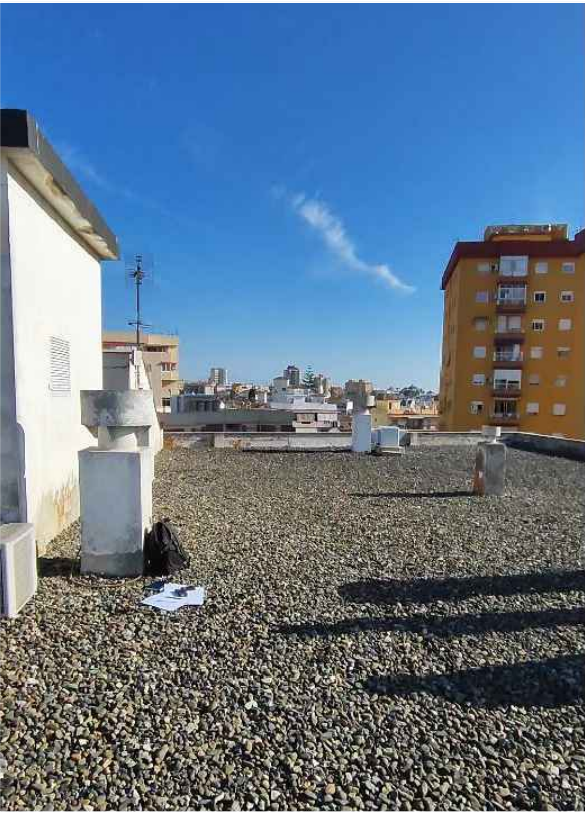
4.- A.1 Mejora de la envolvente térmica: Cubierta existente
