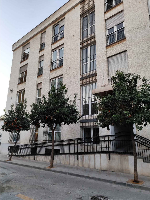
3.- A.1 Mejora de la envolvente térmica: Fachada este - Acceso secundario
