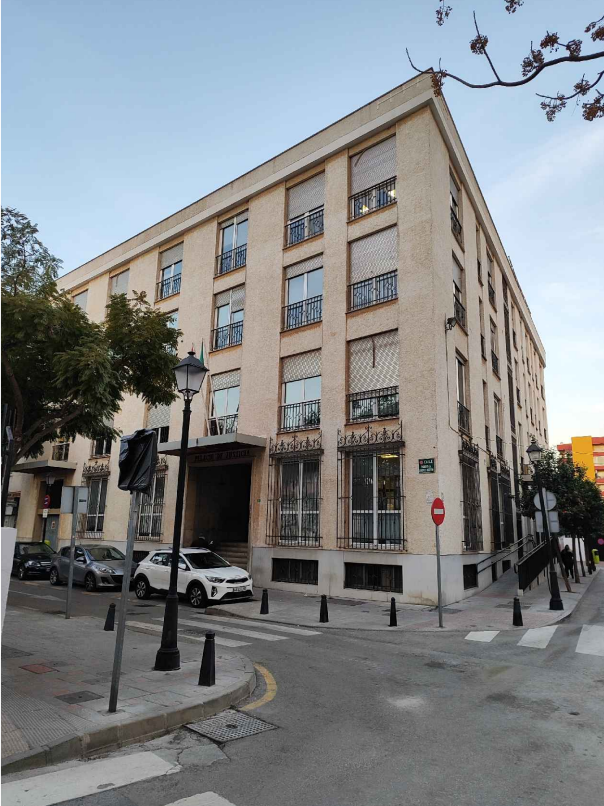
2.- A.1 Mejora de la envolvente térmica: Fachada Sur - Acceso principal
