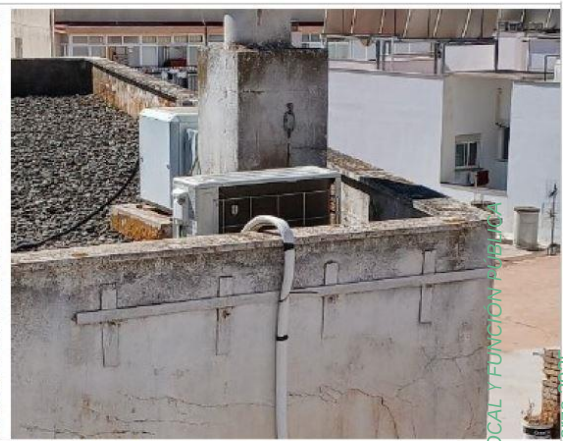
Refuerzos metálicos en esquinas de pretiles de cubierta.
