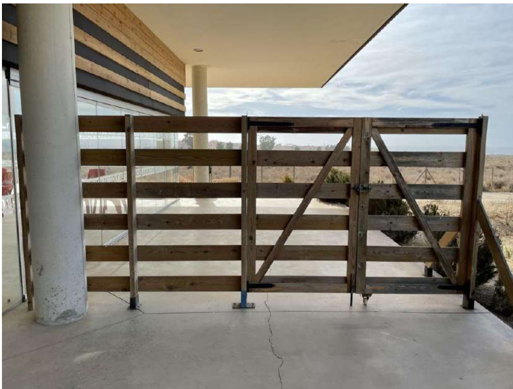
Vallado existente en acceso a zona exterior.
