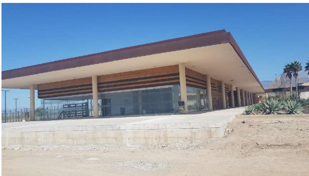
Fachada Este. Exterior zona fitness. Porche cubierto y espacio descubierto.
