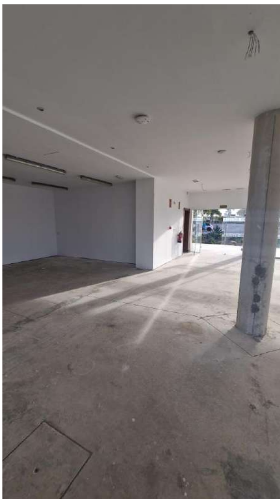
Zona de peso libre. Puerta de acceso al almacén y la sala de instalaciones.
