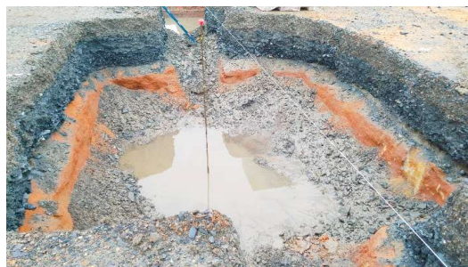
Situación obra a finales de enero
