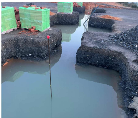
Situación obra a finales de enero
