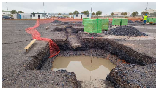
Situación obra a finales de enero
