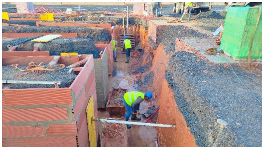
Trabajos de adecuación de foso de los daños producidos
