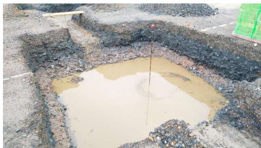
Situación obra a finales de enero
