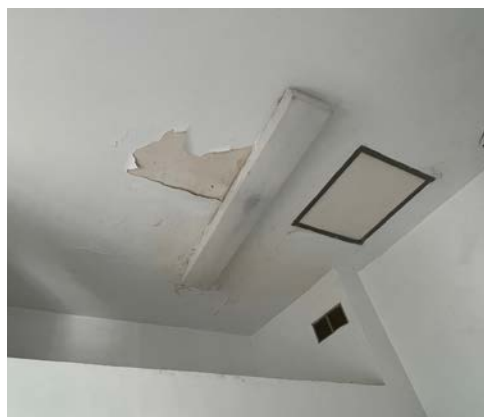
Aseos Planta Baja. Aseo accesible y detalle de techos
