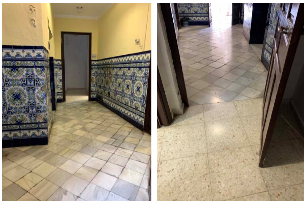
Aseos Planta Baja. Distribuidor previo
