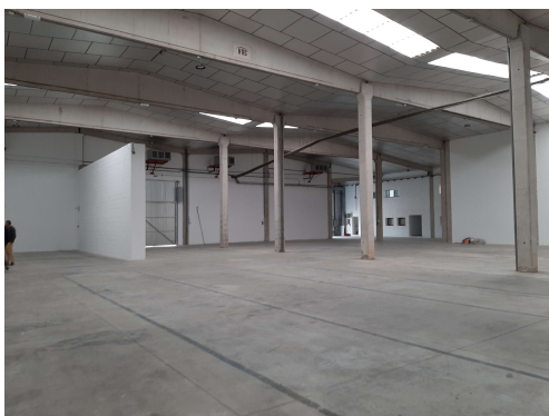
Interior de la nave (área diáfana)
