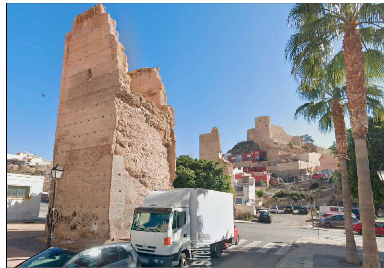
Torre Oeste. Vista Sur-Oeste
