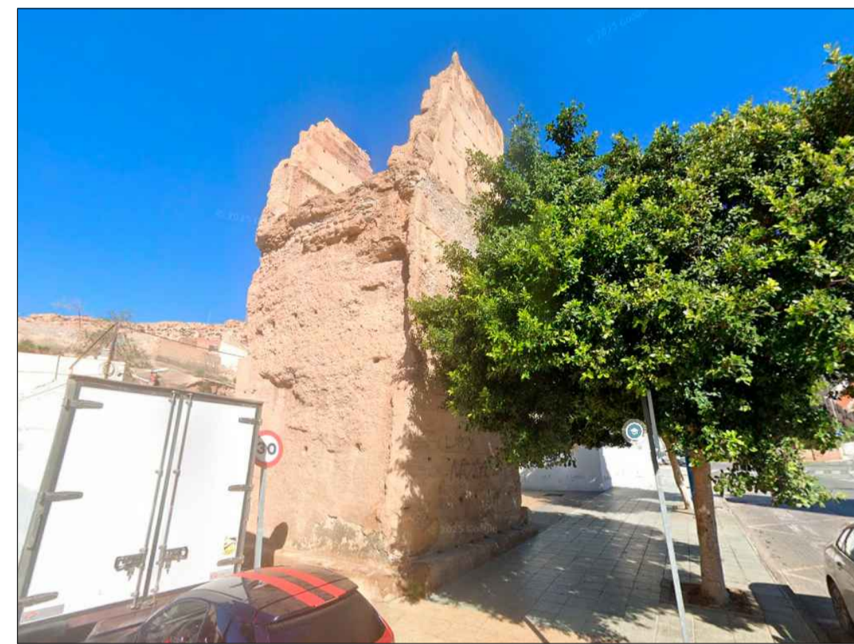
Torre Oeste. Vista Sur
