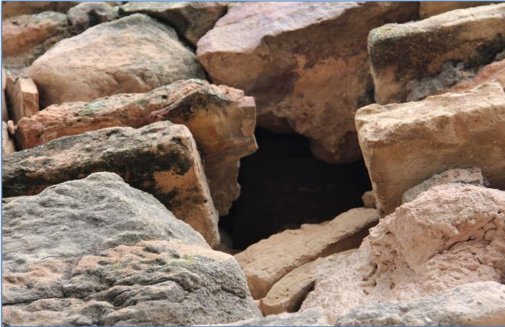
Detalle hueco en lienzo alzado sur
