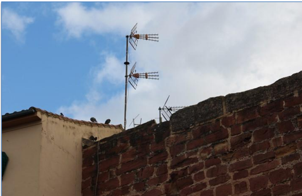
Detalle instalaciones próximas cubierta zona alzado oeste
