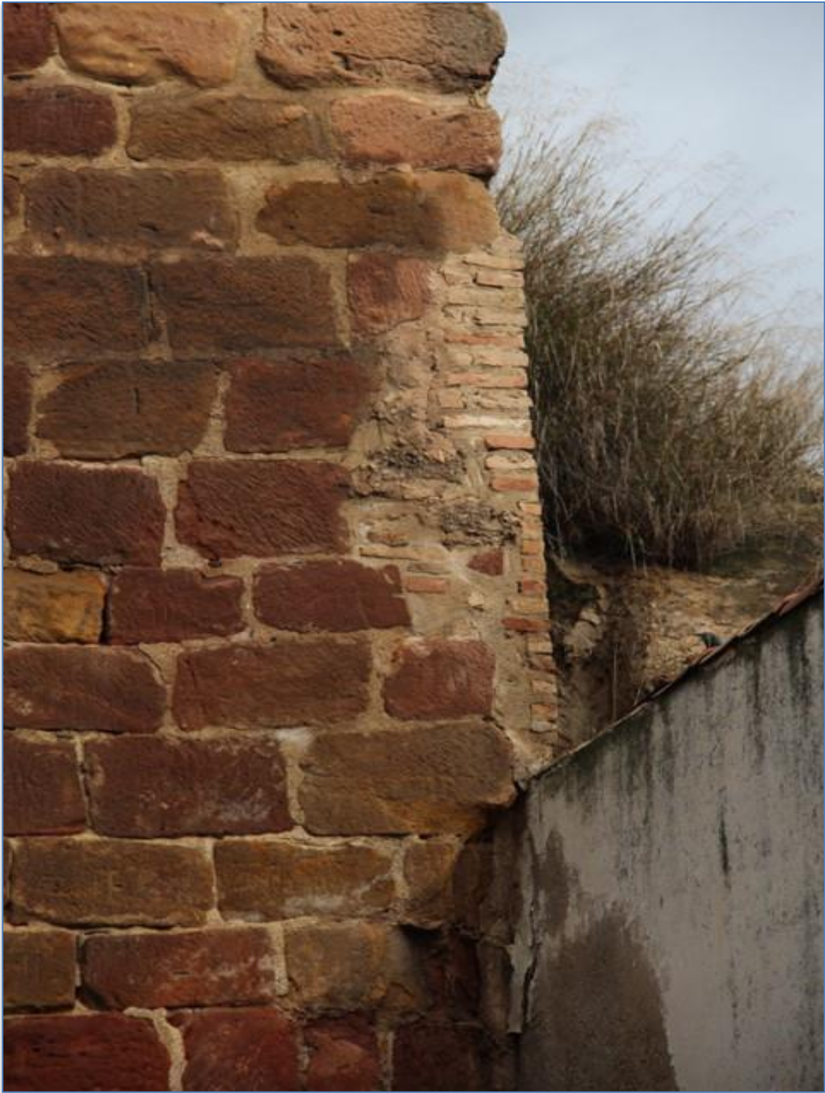
Detalle reconstrucción con materiales contemporáneos
