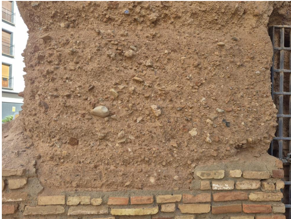
Detalle tapial alzado sur
