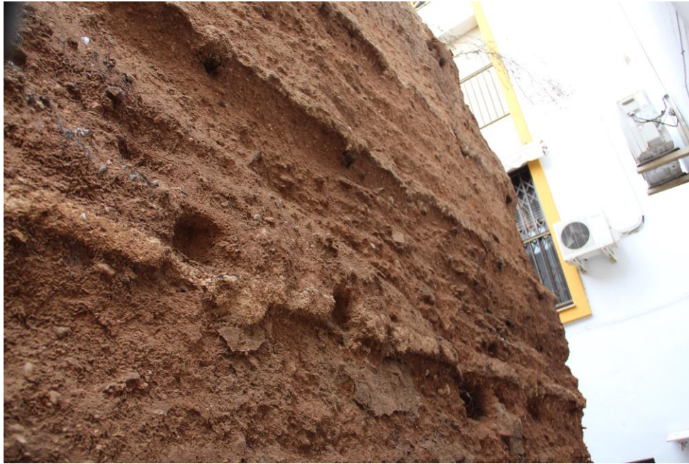
Detalle calicostra alzado sur
