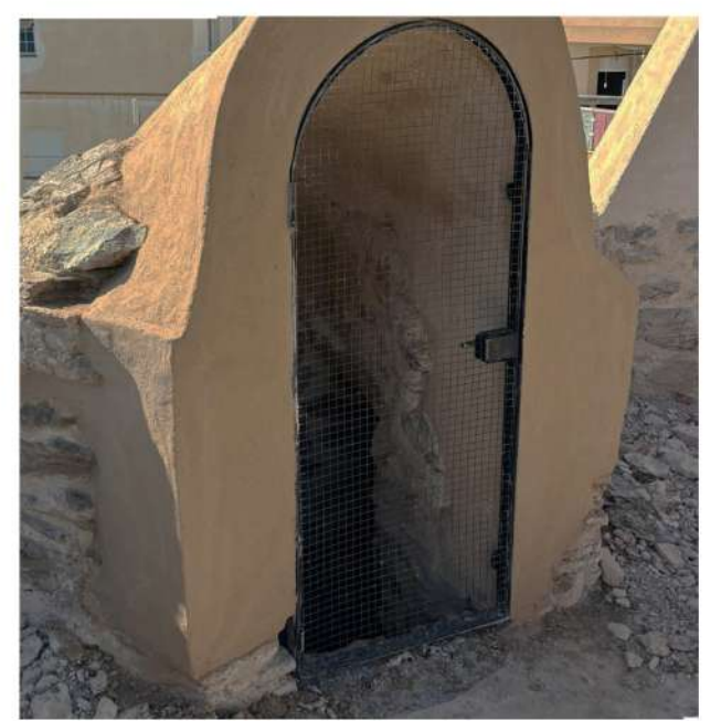
Se colocará un cancela sencilla sin impacto visual en la puerta de entrada para no acceso de animales. no se colocará a ras.
