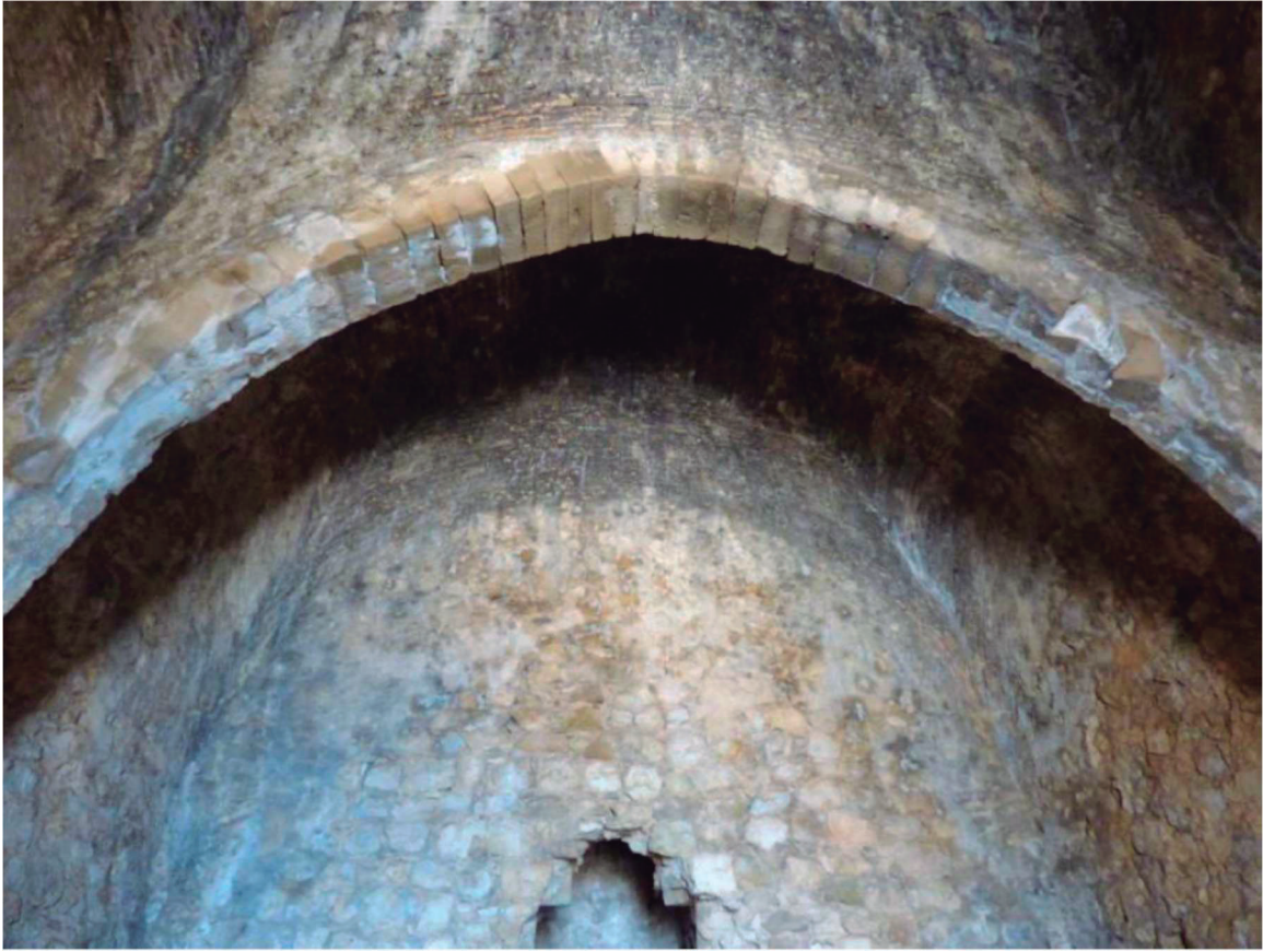
Arco apuntado y bóvedas de ladrillo que rematan la estancia inferior de la torre
