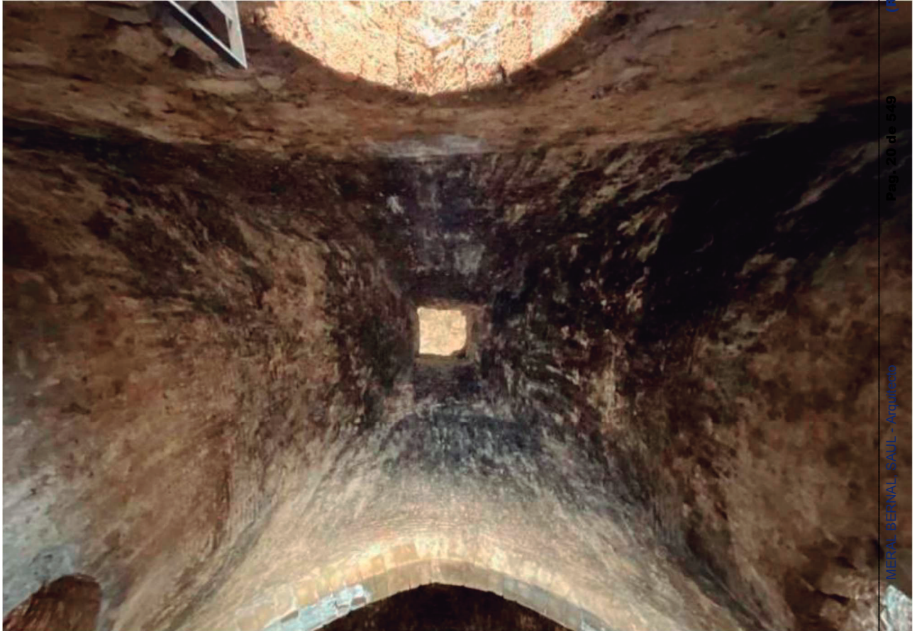
Detalle bóveda Torre del Homenaje
