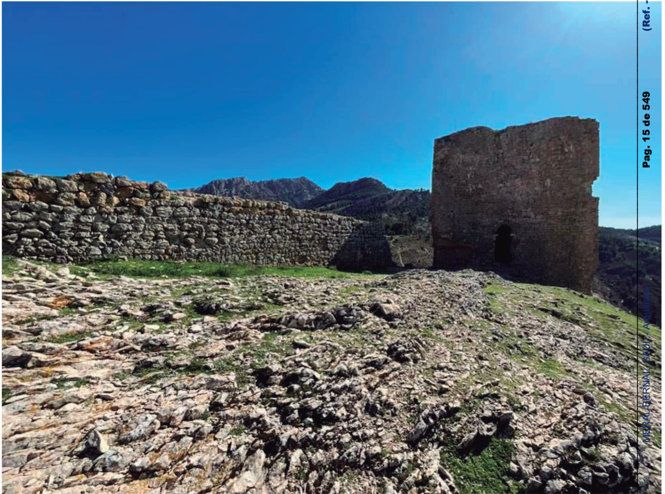
Reciento exterior. El recinto exterior estaba constituido por un muro de mampostería en hiladas regulares extremadamente grueso (2,55 m.).
