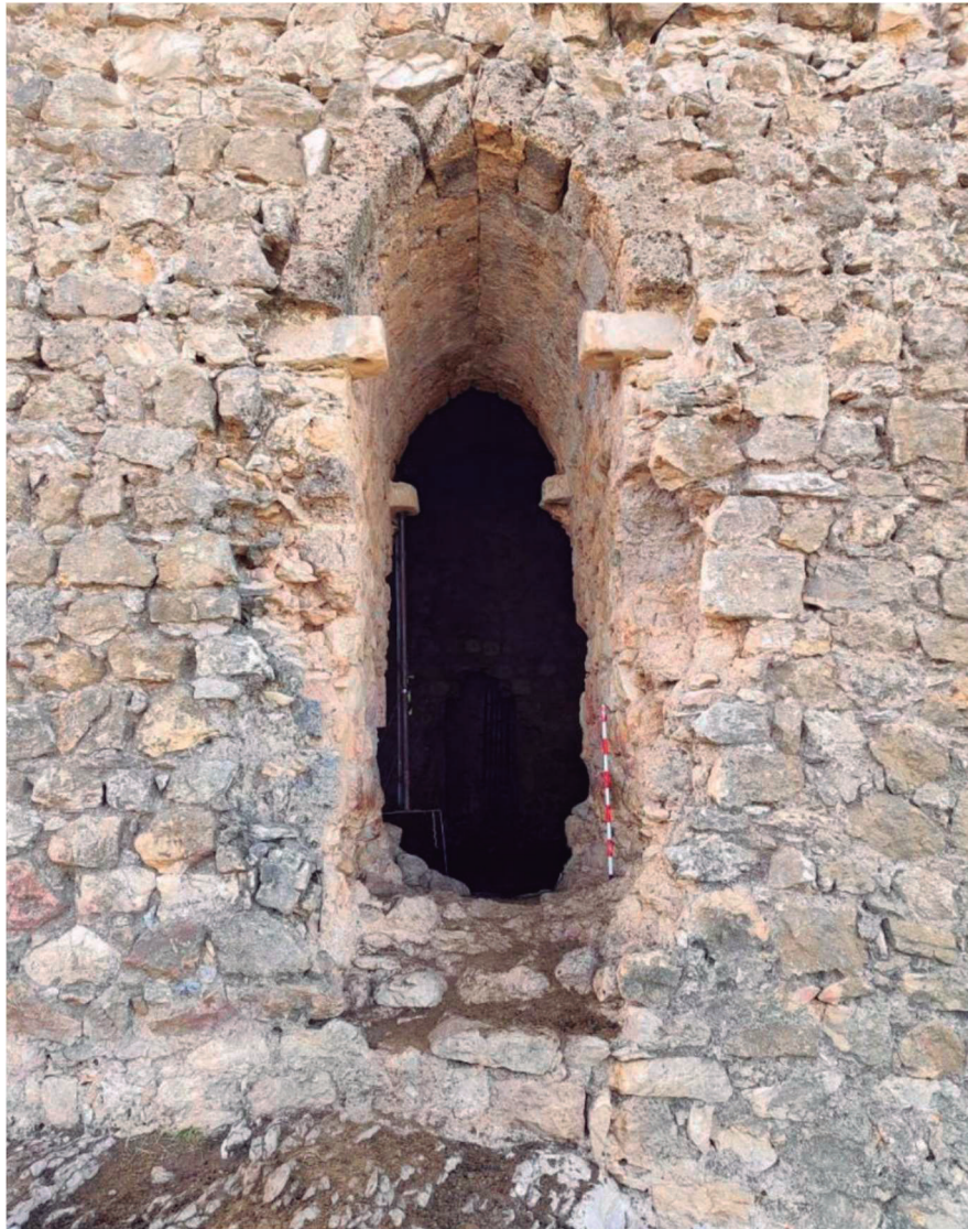
Vano de acceso al interior de la Torre del Homenaje
