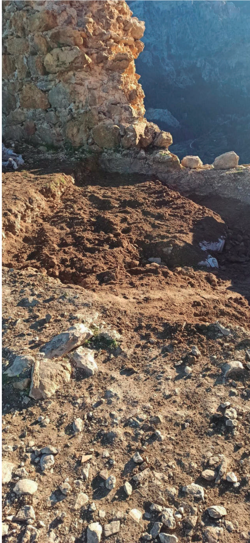
Figura 67: Fotografía del tapado del sondeo 2, con geotextil en la parte inferior.
