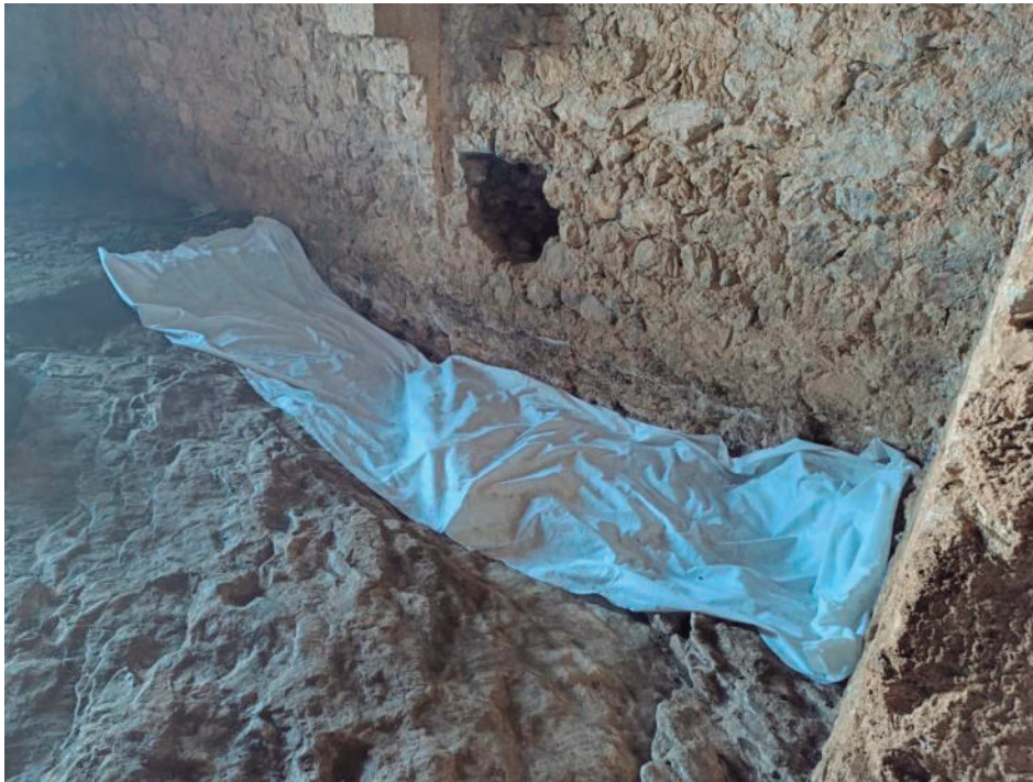
Figura 72: Geotextil que se ha utilizado para el sondeo 4.
