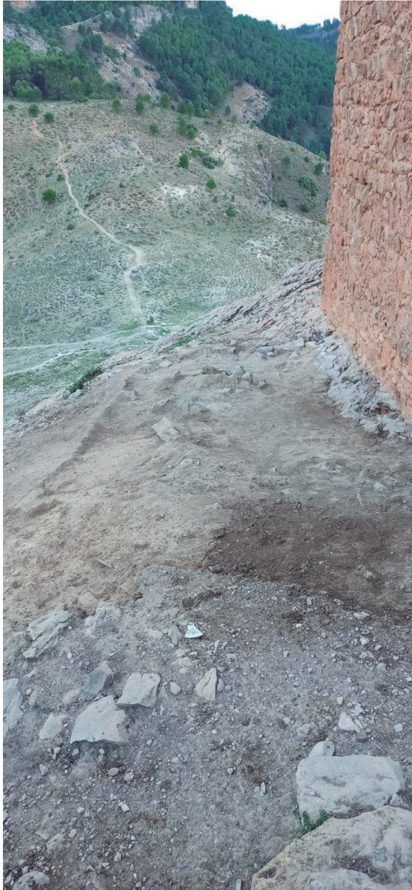
Figura 16: Flujo de trabajo realizado en el sondeo 1.
