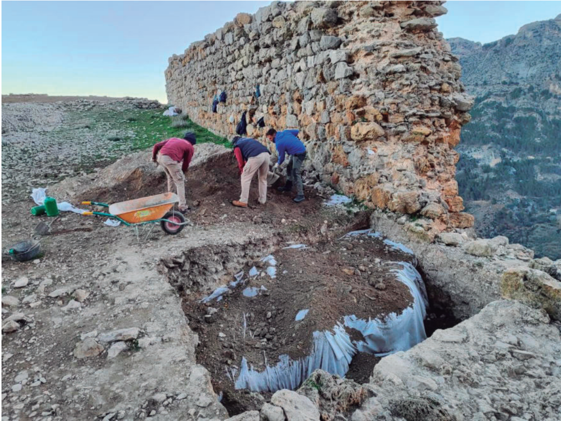
Figura 64: Fotografía del tapado del sondeo 2, con geotextil en la parte inferior.
