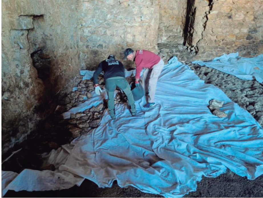
Figura 74: Fotografía del tapado del sondeo 4, con geotextil en la parte inferior.
