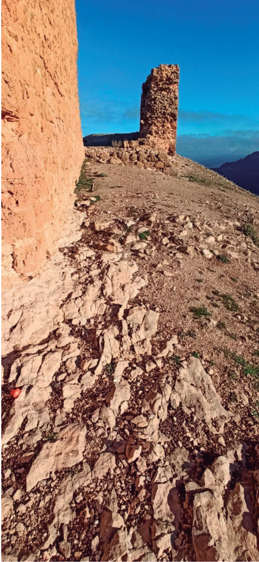
Figura 9: Sondeo 1 antes de ser intervenido.
