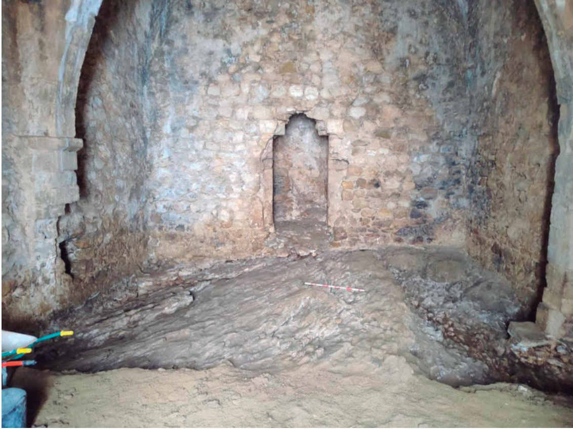
Figura 62: Foto final del sondeo 4 (interior de la torre del homenaje).
