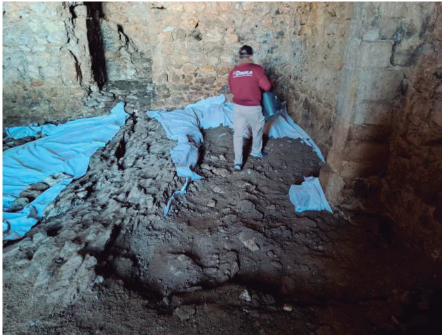
Figura 70: Fotografía del tapado del sondeo 4, con geotextil en la parte inferior.
