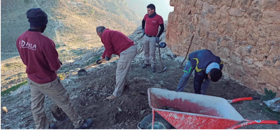
Figura 23: Flujo de trabajo realizado en el sondeo 1.
