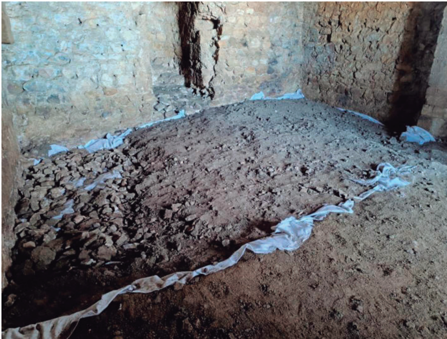
Figura 75: Fotografía del tapado del sondeo 4, con geotextil en la parte inferior.
