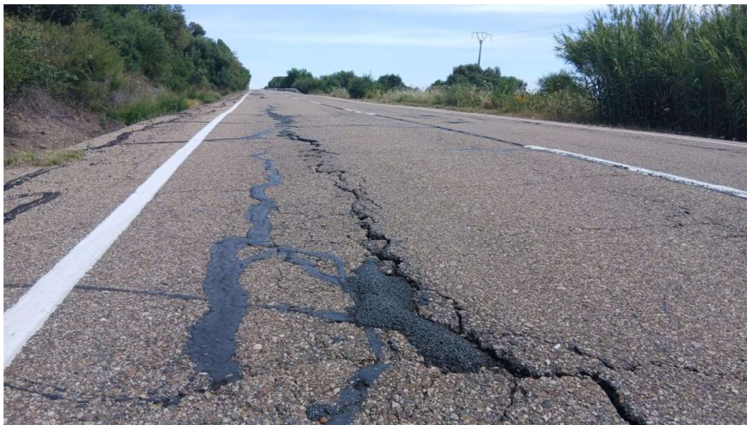
Foto N° 7: Fotos del estado del firme en la A-477 p.k. 27+200 al 27+502
