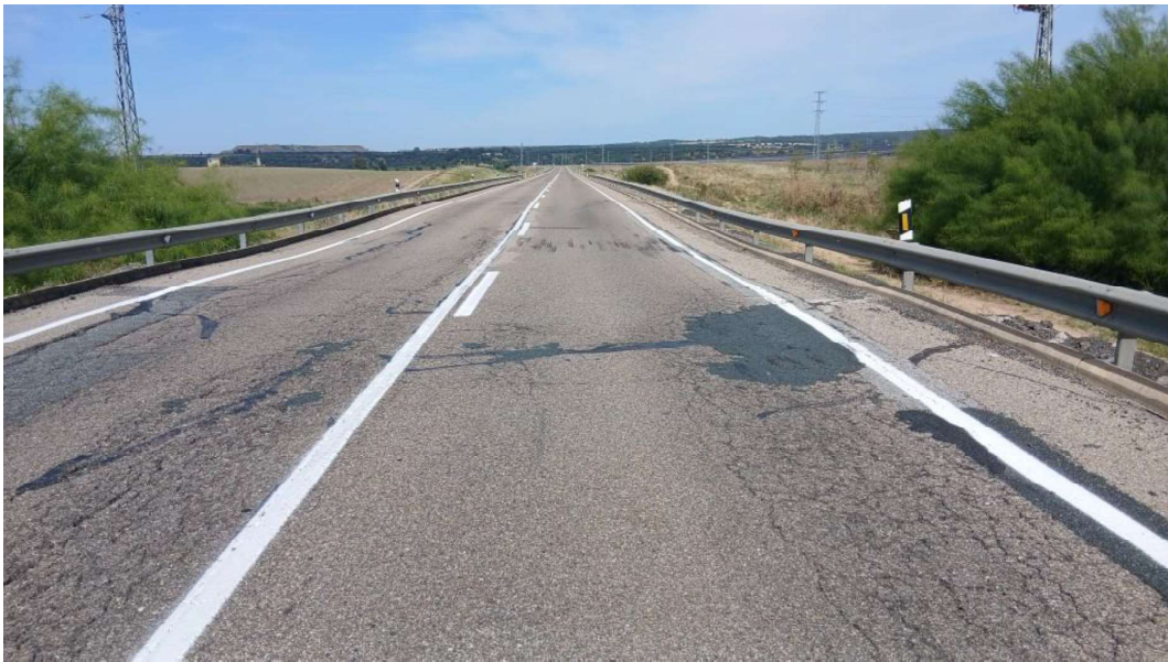
Foto N° 2: Fotos del estado del firme en la A-477 p.k. 7+500 al 7+625
