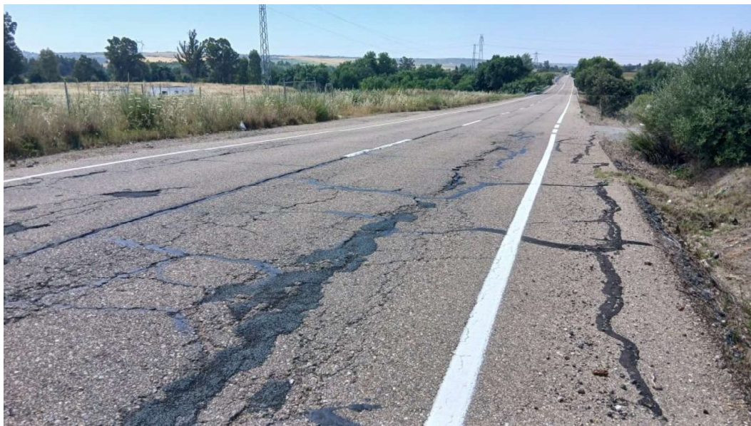
Foto N° 8: Fotos del estado del firme en la A-477 p.k. 27+200 al 27+502
