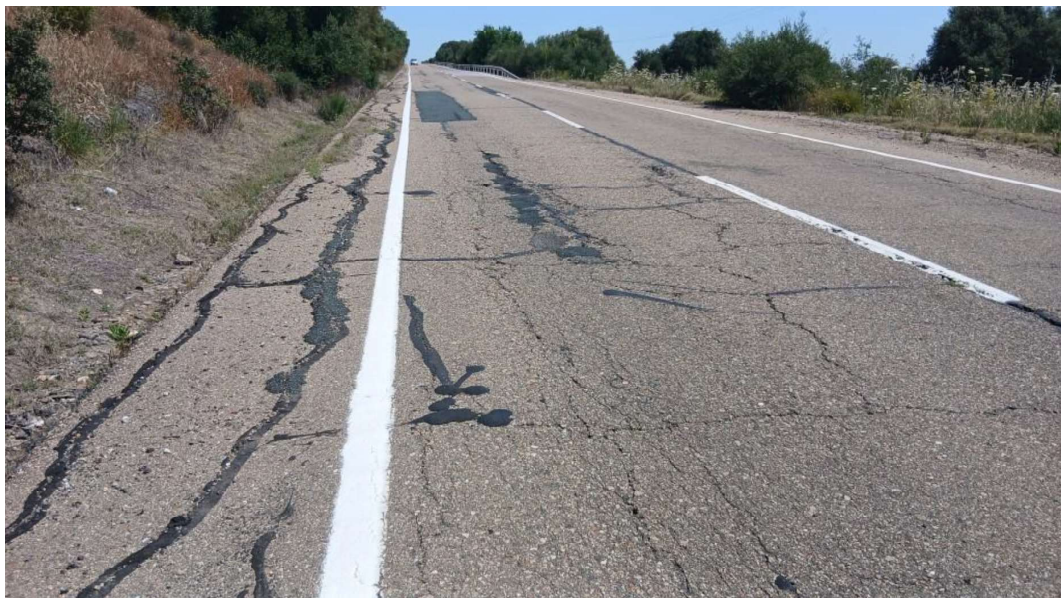
Foto Nº 12: Fotos del estado del firme en la A-477 p.k. 27+200 al 27+502
