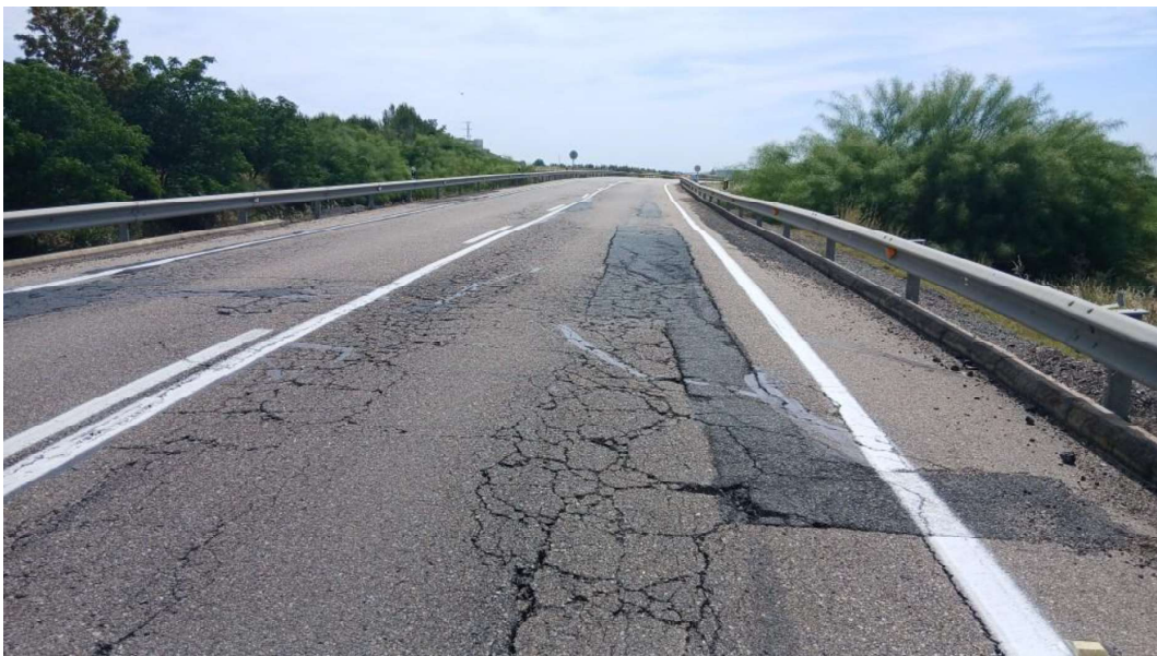
Foto N° 4: Fotos del estado del firme en la A-477 p.k. 7+500 al 7+625
