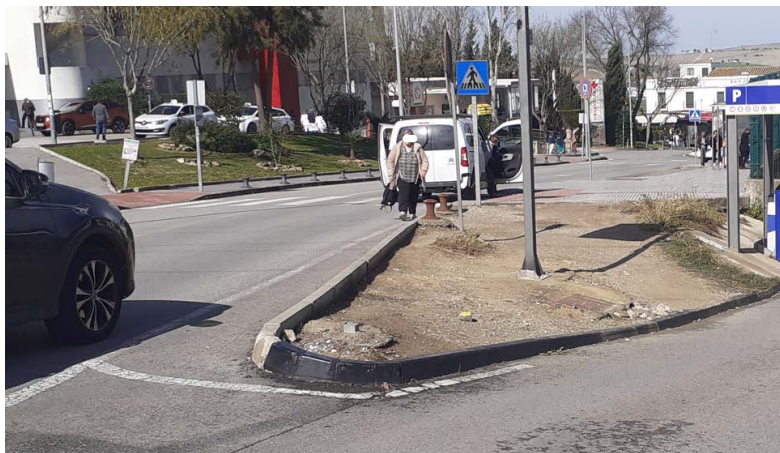
Ilustración 5 Vista del paso de peatones nº3, y zona prevista con ampliación de acerado
