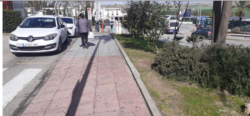
Foto 9 Vial interior para conexión con acceso al edificio Hospital General.
