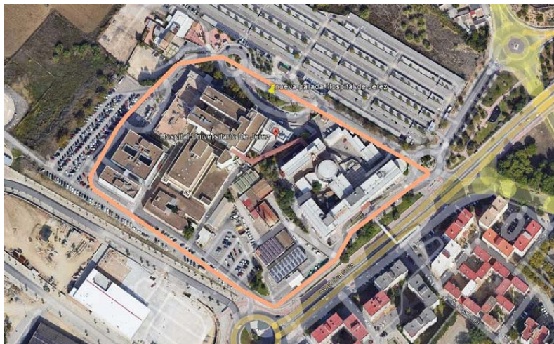
Ilustración 1 Vista general Hospital Universitario de Jerez. Sombreado: vial principal
