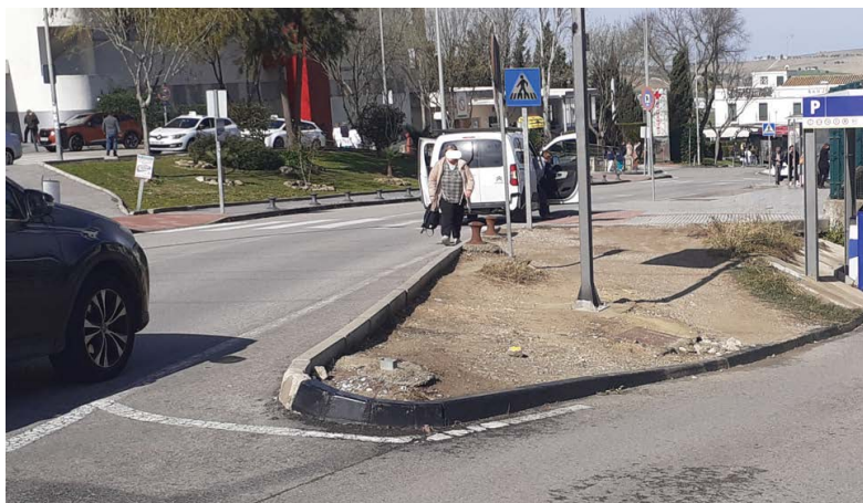
Ilustración 5 Vista del paso de peatones nº3, y zona prevista con ampliación de acerado
