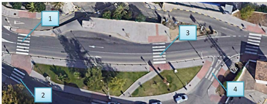
Ilustración 4 Vista general con ubicación de pasos de peatones afectados por la construcción de la parada
