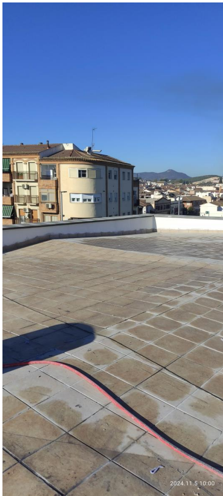
Imagen general de la cubierta donde se instalarán las placas fotovoltaicas
