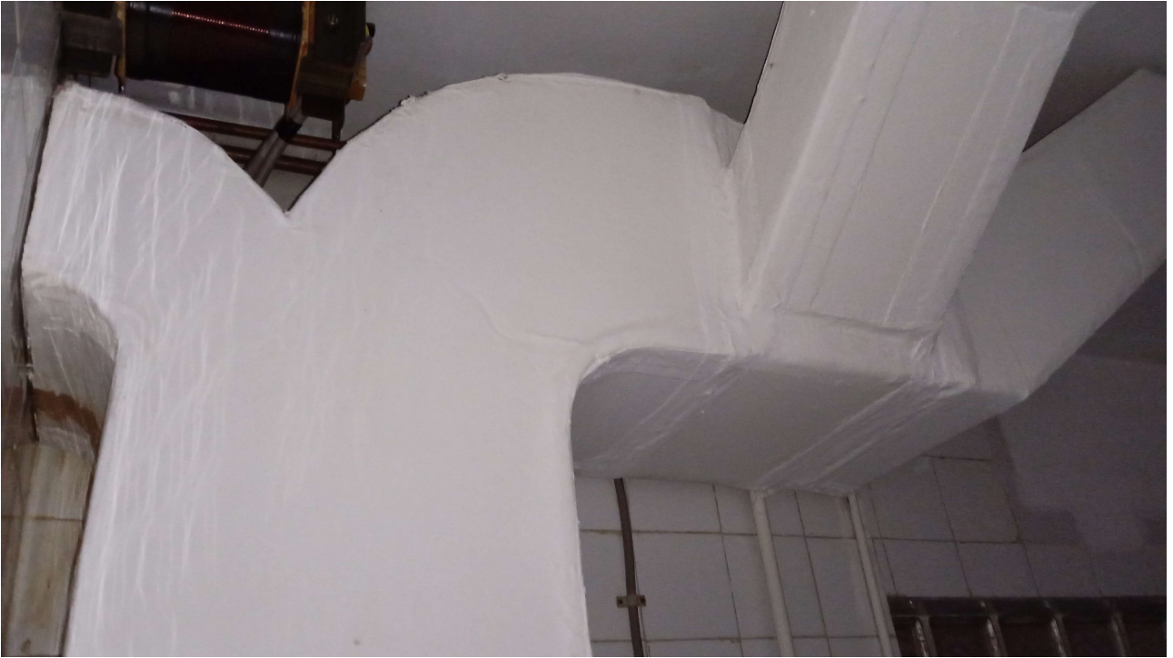
Instalación aire acondicionado (A2)
