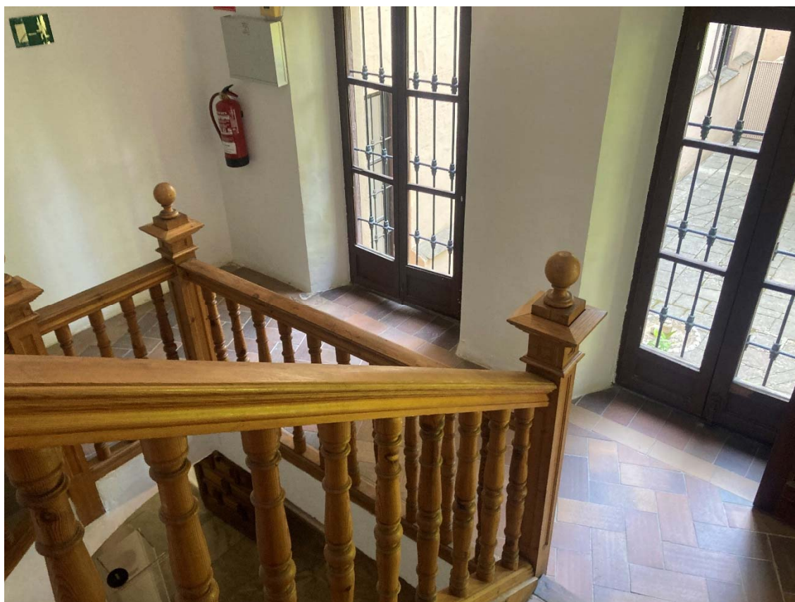
Primer rellano con parada del ascensor
