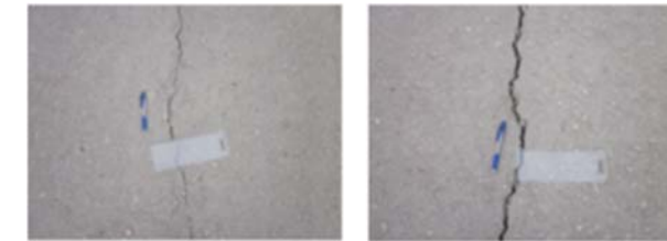
Tipo de fisura según abertura
