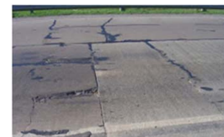
Tipos de fisura según la orientación
