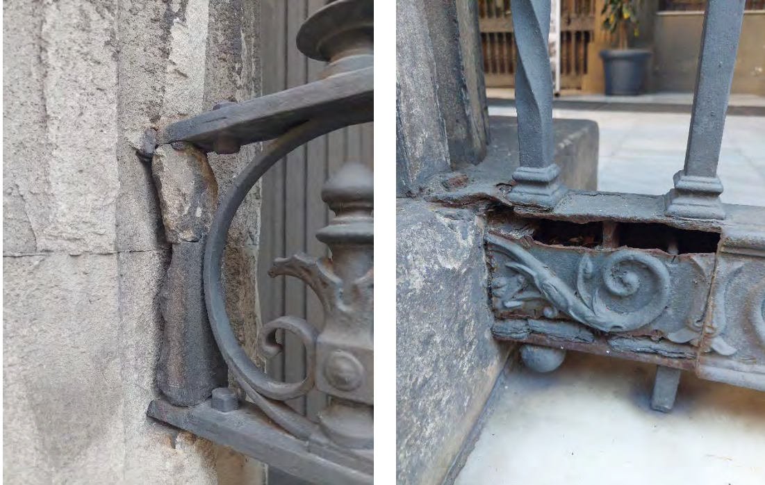
En la imagen izquierda anclaje superior del tramo izquierdo. A su derecha, anclaje inferior del tramo central
