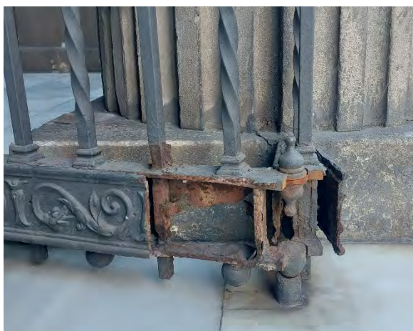
En la imagen superior, friso inferior con la secuencia de tramos de placas rectangulares decoradas con roleos. En las imágenes inferiores, se pueden observar detalles de la estructura interna del friso inferior
