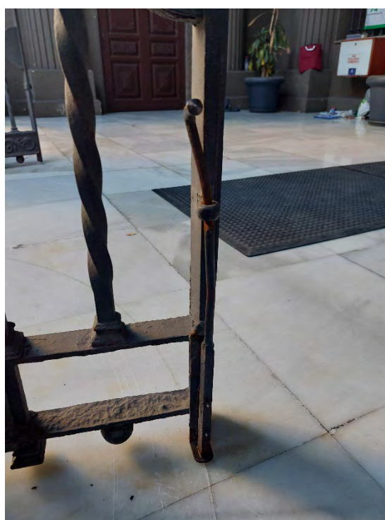
Detalles de los sistemas de cierre horizontal y vertical de la cancela
