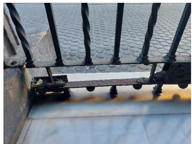
En la imagen superior, friso inferior con la secuencia de tramos de placas rectangulares decoradas con roleos. En las imágenes inferiores, se pueden observar detalles de la estructura interna del friso inferior
