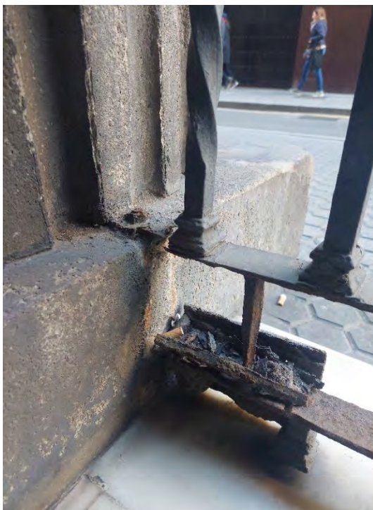
Detalle de la rotura de los anclajes inferiores del tramo izquierdo, por corrosión de los travesaños
