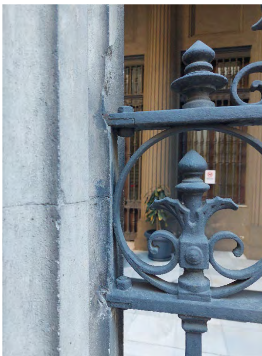
A la izquierda, ensambles superiores del tramo derecho. A su derecha, anclaje del tramo central
