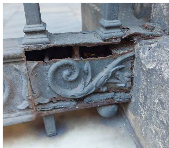
En la imagen superior detalle de una placa completa con montada con tornillería. Abajo a la izquierda obsérvese la sección de la placa y el interior con pasador entre las placas, a su derecha tercio de placa para remate del extremo.
