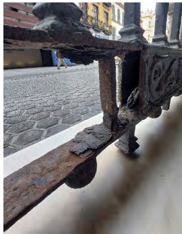
En la fotografía superior corrosión deformante con laminación de una placa. En las imágenes inferiores travesaños con corrosión.
