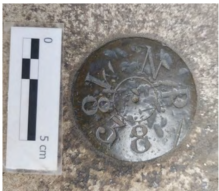
Placa y clavo de nivel de precisión, indicando la altitud sobre el nivel del mar del edificio como punto de referencia
