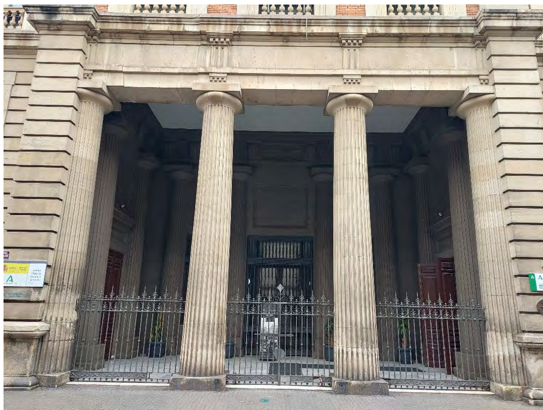
Vista general del pórtico con la verja
