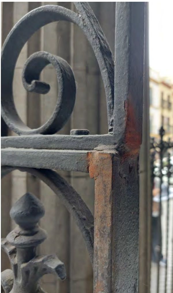
A la izquierda detalle de soldadura en la pieza de cierre lateral de la cancela izquierda. En la imagen derecha detalle de soldadura en la caja de la cerradura
