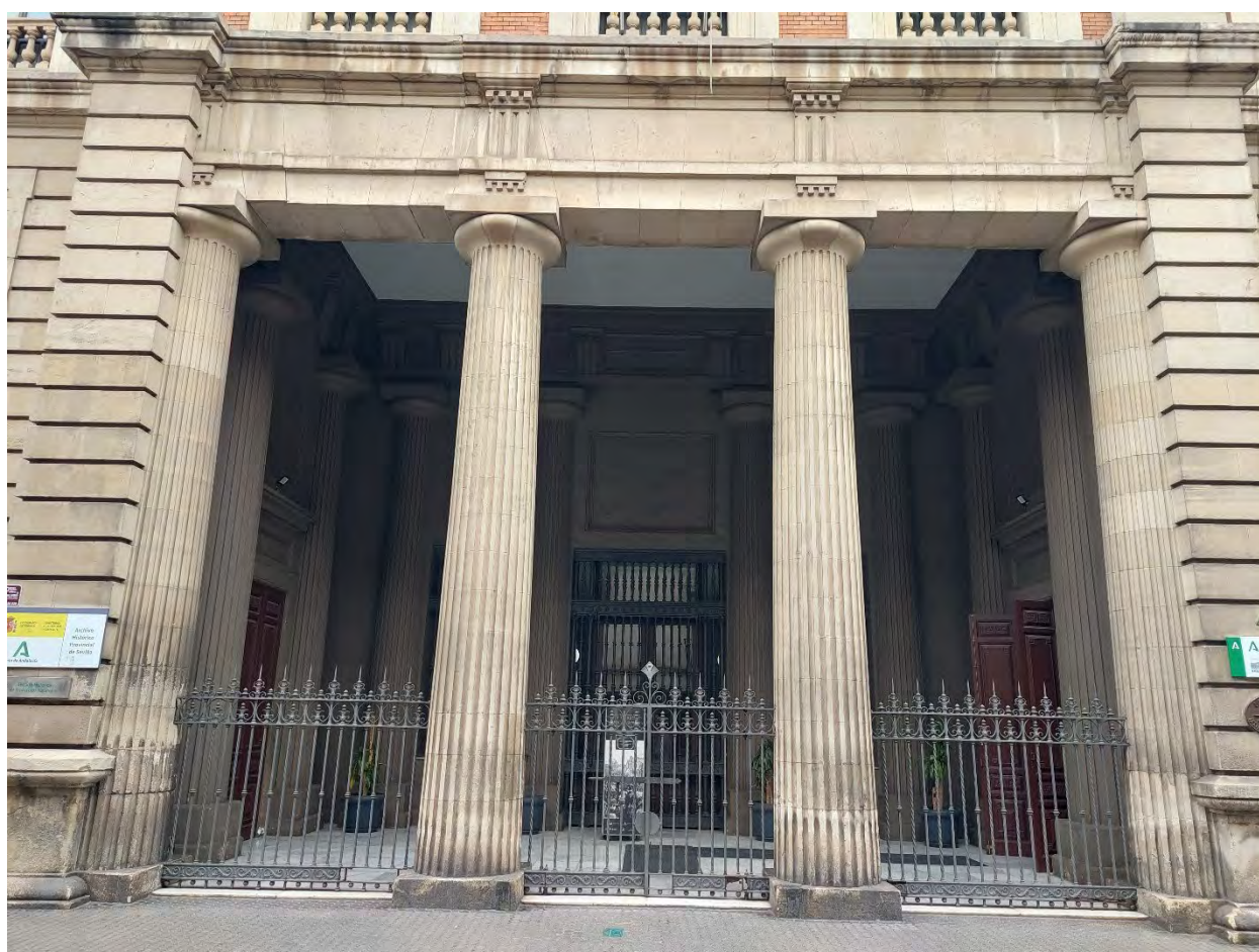
Vista general de la verja, situada en el pórtico principal de entrada al edificio del Archivo
