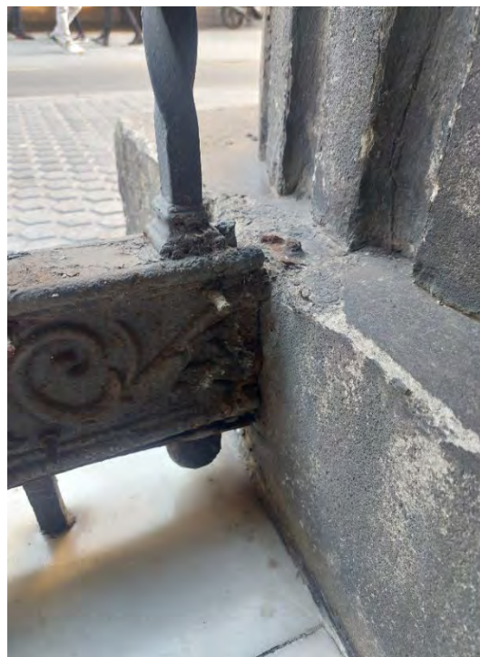
Detalle de la rotura de los anclajes inferiores del tramo izquierdo, por corrosión de los travesaños
