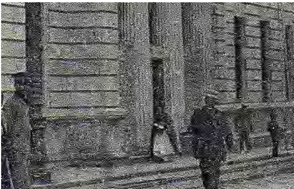
Detalle en el que se percibe entre las columnas una entrada central adintelada y los vanos laterales cegados
