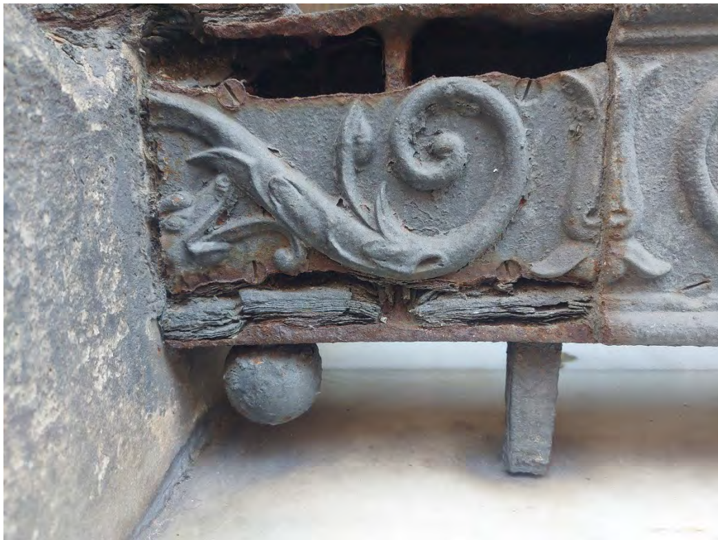
En la fotografía superior corrosión deformante con laminación de una placa. En las imágenes inferiores travesaños con corrosión.
