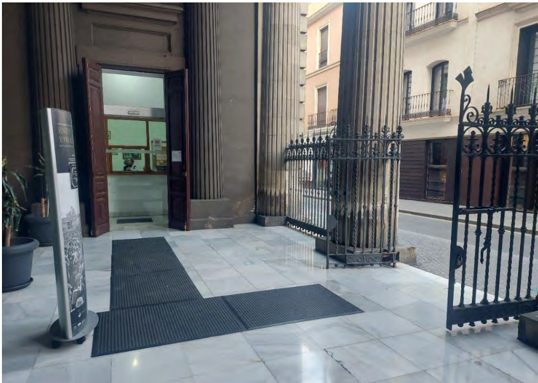
Vista general del atrio del edificio con la puerta de acceso activa en el lateral.
