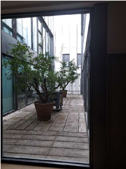
Nuevo hueco a apertura en patio y demolición de cancela Instalación de barras antipánico, cierrapuertas, señalética y protección anti-intrusión
