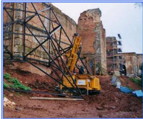
Al extremo superior del tubo va enroscado el varillaje, generalmente de 42 o 50 mm (hueco), para permitir que pase el agua proveniente de la bomba.
