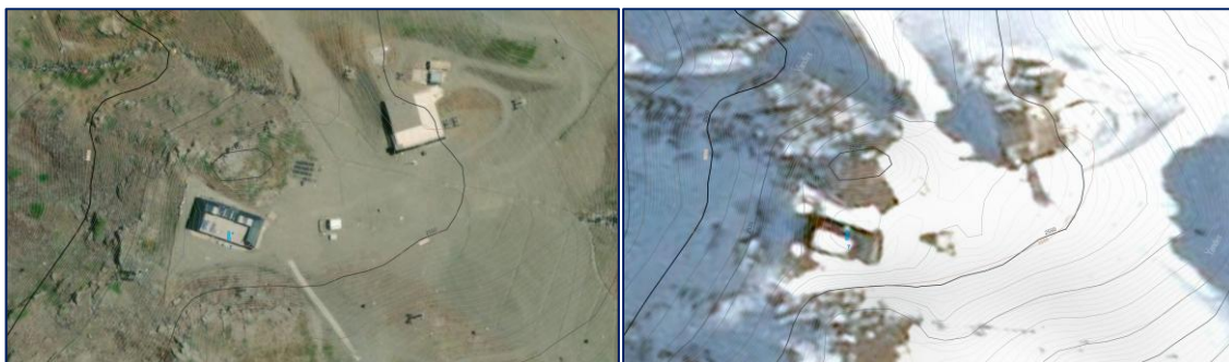
Ilustración 5. Vista satélite del edificio compresores (modo verano y modo invierno).
