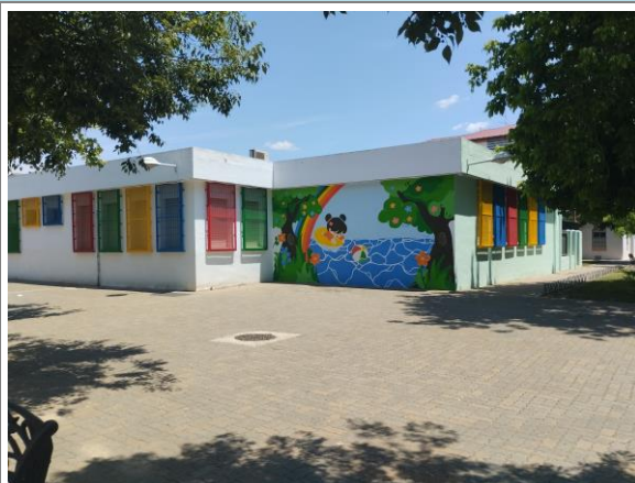
Fachada principal edificio
