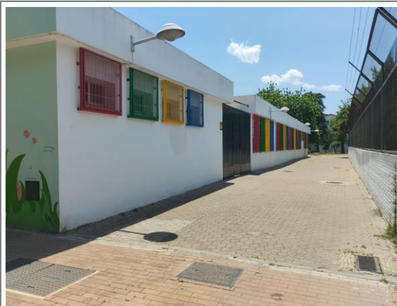
Fachada lateral: entrada secundaria
