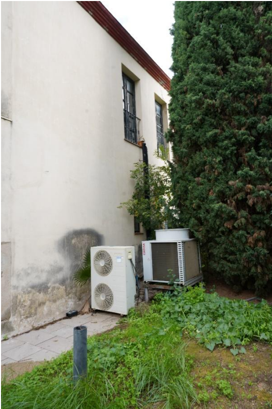
Fachada sur. Zona junto a la tapia hacia el río.
