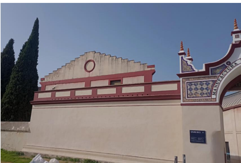
Fachada este. Zona junto a la puerta del río
