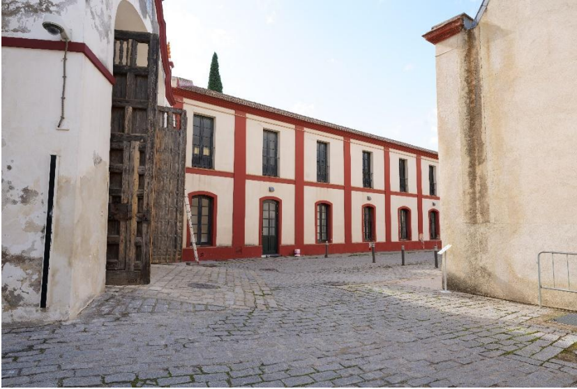
Vista general de la fachada norte. Zona junto a la puerta del río.
