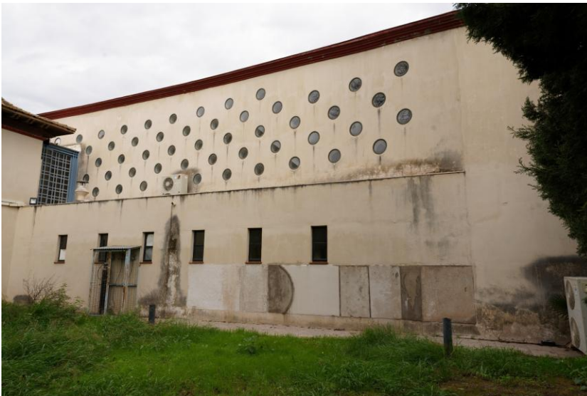
Vista parcial de la fachada sur.
